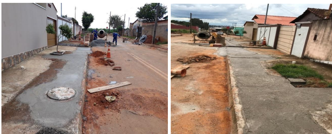
Figura 27 – Recuperação da área escavada
