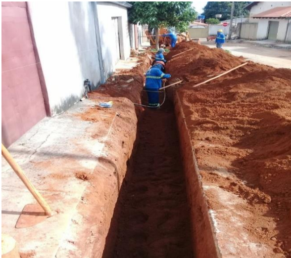
Figura 19 – Escavação sem Escoramento
