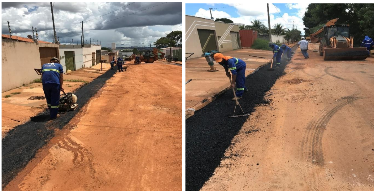
Figura 26 – Aplicação da Base Asfáltica
