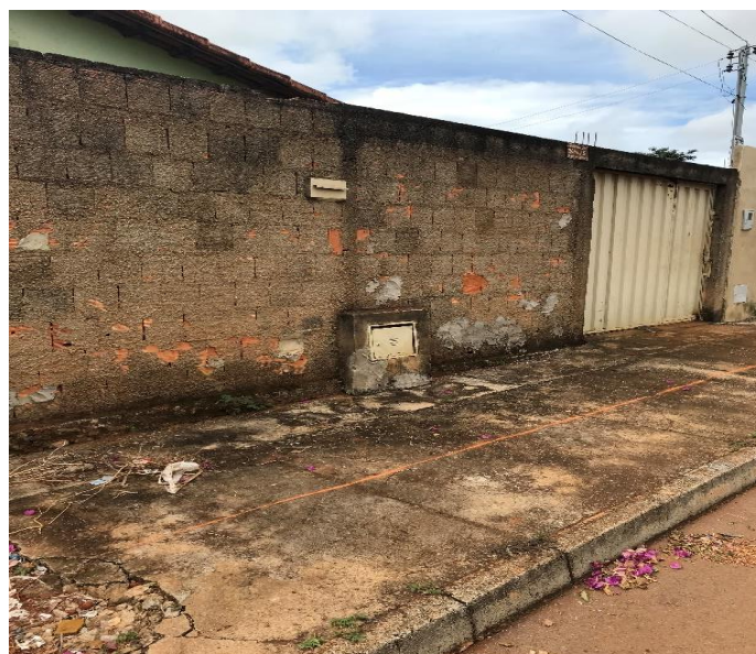
Figura 15 – Calçada degradada
