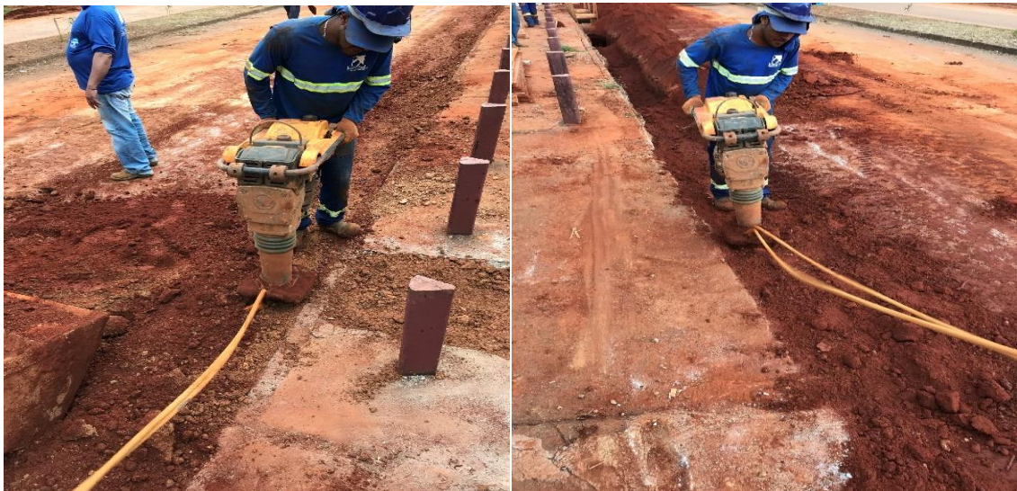
Figura 23 – Compactação com compactador tipo sapo
