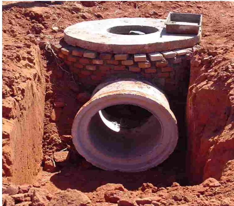
Figura 1 – Poço de visita em construção
