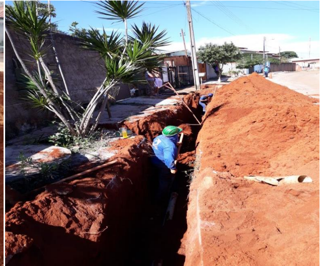
Figura 19 – Escavação sem Escoramento
