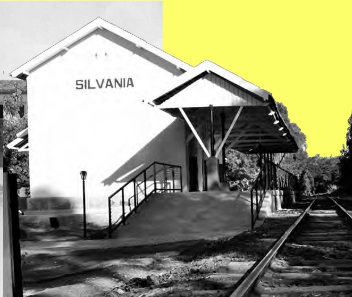
Foto 3: Estação Ferroviária, Silvânia-Go.
