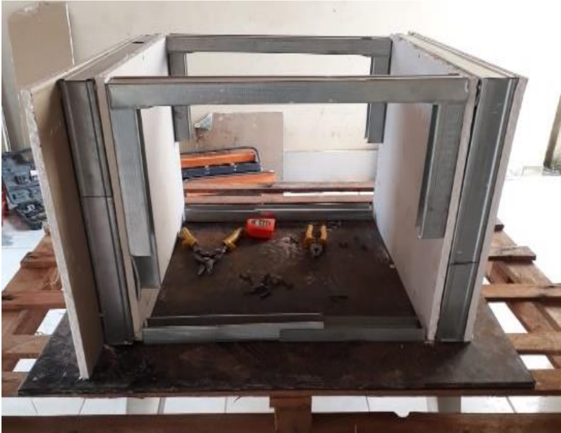
Figura 12. Fechamento com as placas de drywall.
