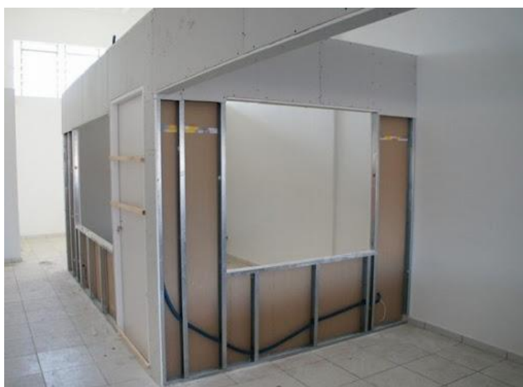
Figura 3. Parede de drywall
