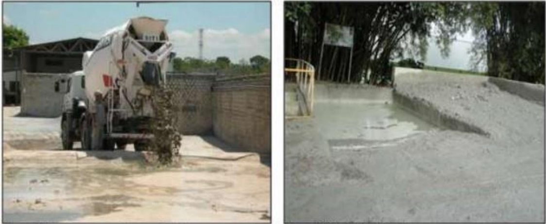
Figura 7 - Decantação é técnica viável para tratamento e reúso da água pela construção civil.
