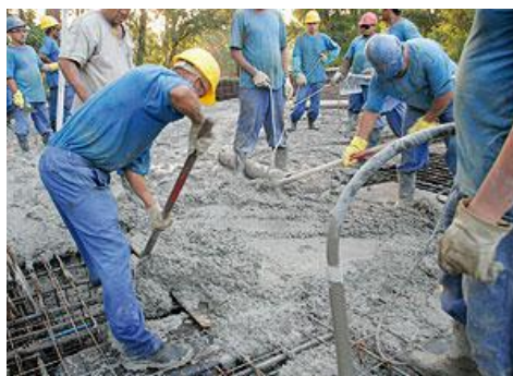
Figura 21 – Concretagem
