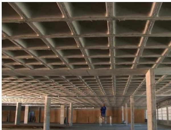
Figura 13 – Laje Nervurada
