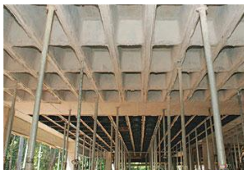
Figura 24 – Reescoramento da laje nervurada
