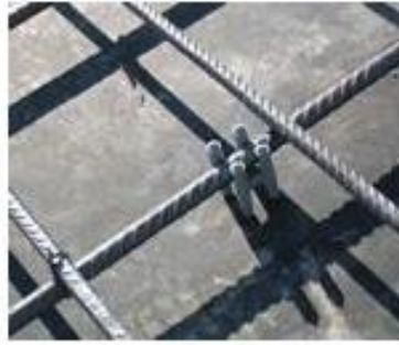
Figura 8 - Distanciador tipo cadeirinha de aço
