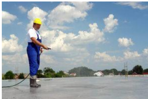
Figura 23 – Cura do concreto
