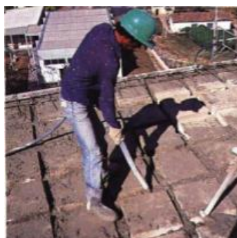
Figura 22 – Vibração nas nervuras
