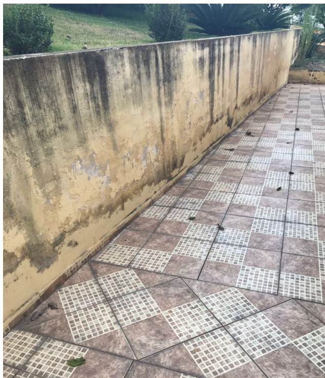
Figura 30: Muro de Arrimo (Chácara).
