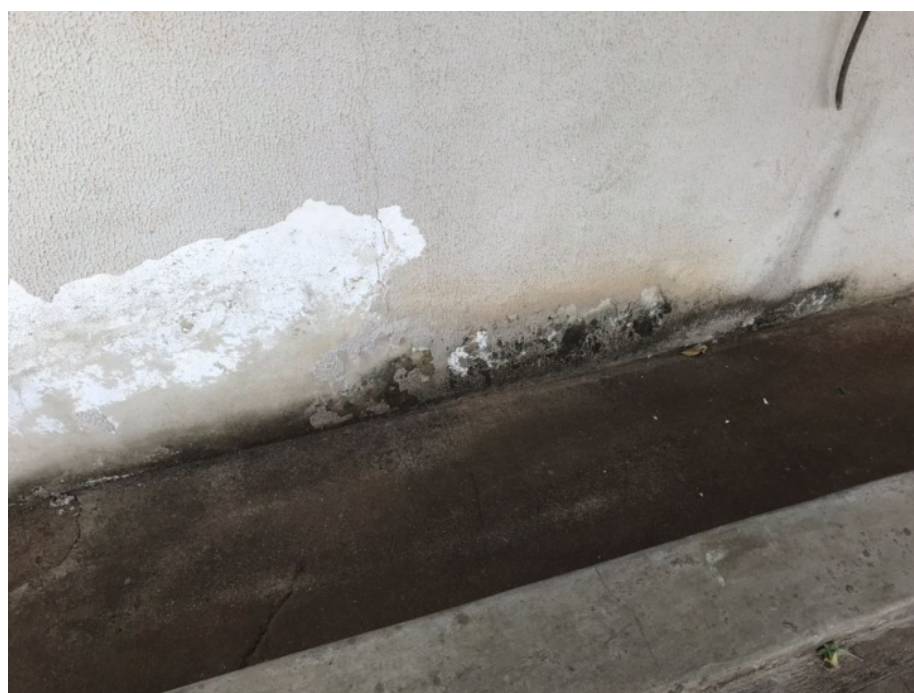
Figura 23: Mofo parede.
