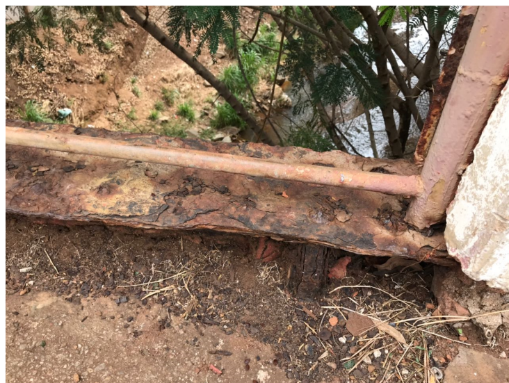
Figura 27: Ferrugem, ponte.
