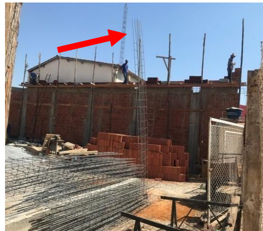
Obra H (b)
