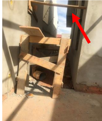
Obra B (b)
