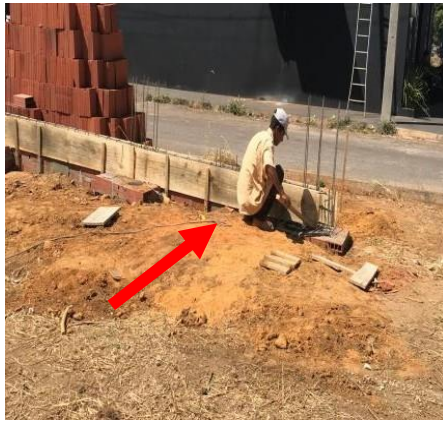
Obra G (a)
