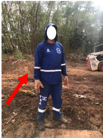
Obra D (a)
