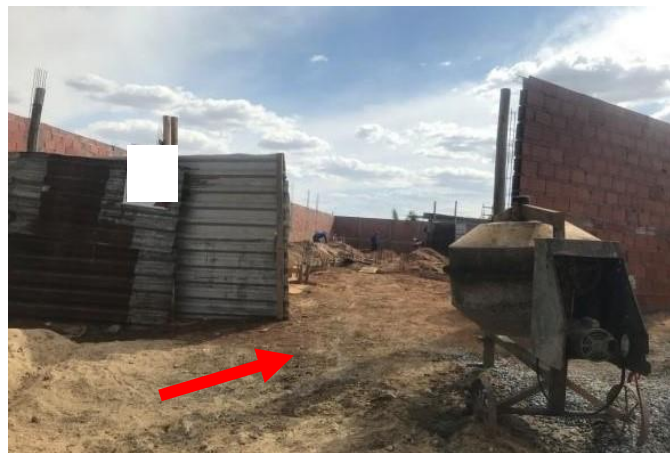
Obra I (b)
