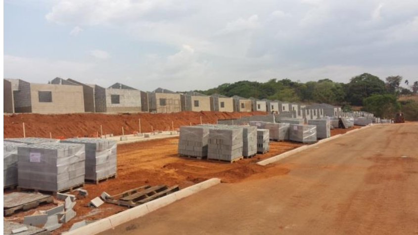
Figura 23 - Distribuição dos blocos de concreto nos lotes
