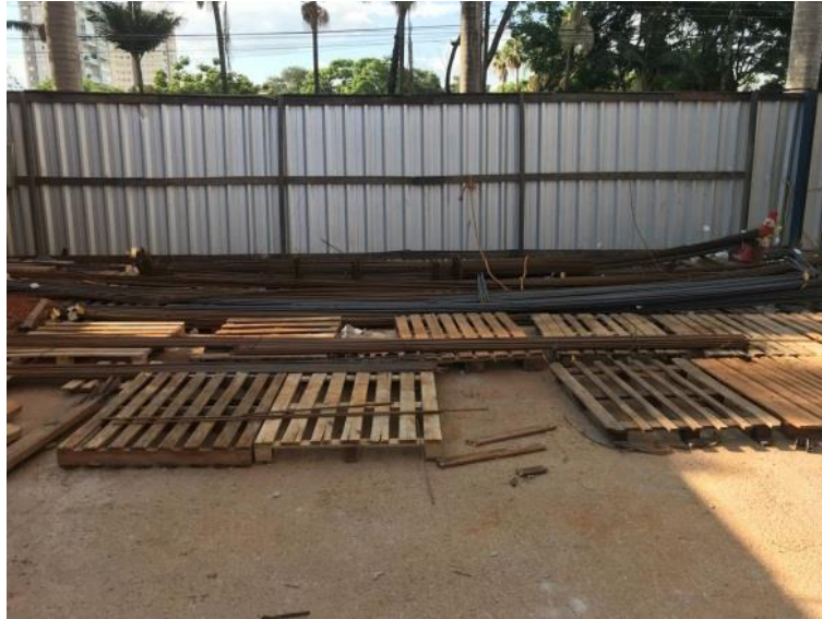
Figura 10 - Armazenamento de material
