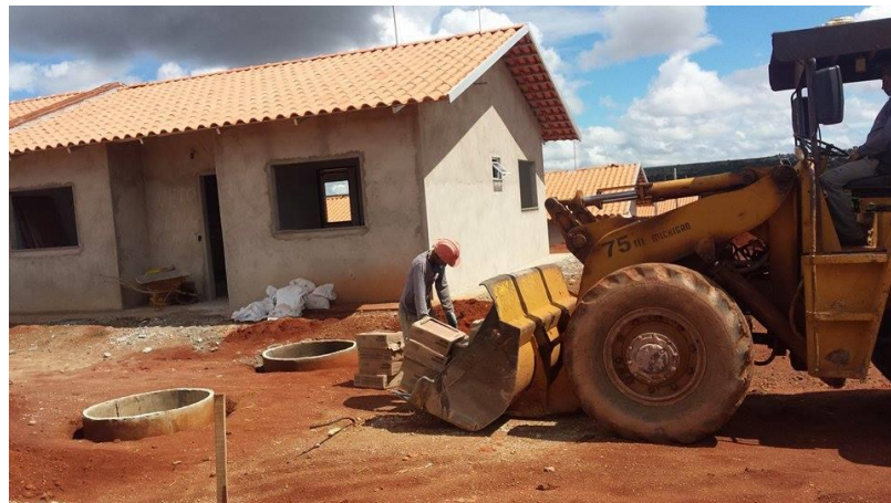
Figura 18 - Pá carregadeira transportando
