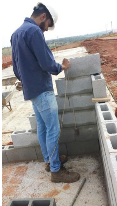
Figura 16 - Aferição de serviço de alvenaria
