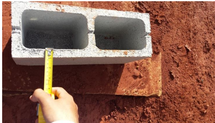
Figura 17 - Conferência de dimensões dos blocos de concreto
