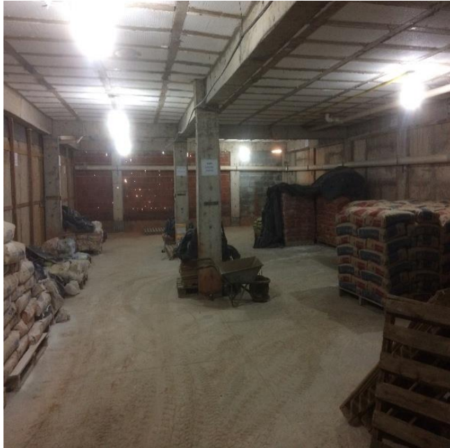
Figura 12 - Limpeza no canteiro de obras
