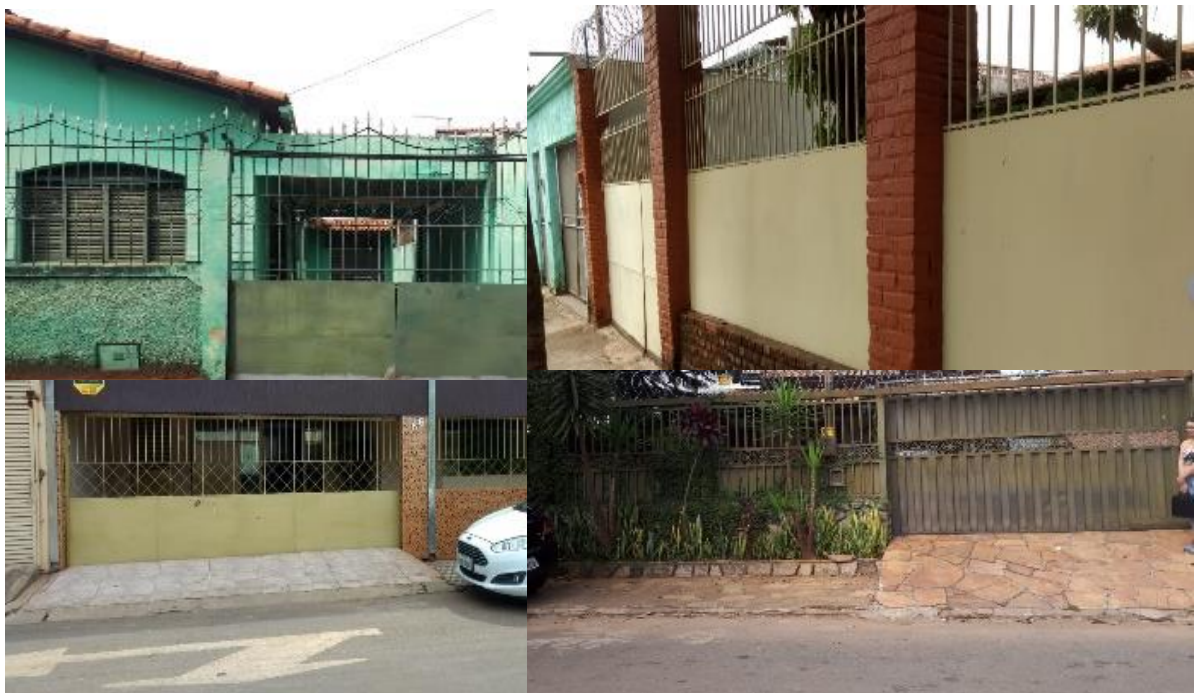
Figura 29 – Portões de contenção nas residências
