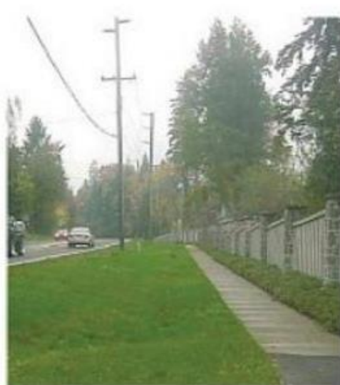
Figura 14 – Valetas de Infiltração
