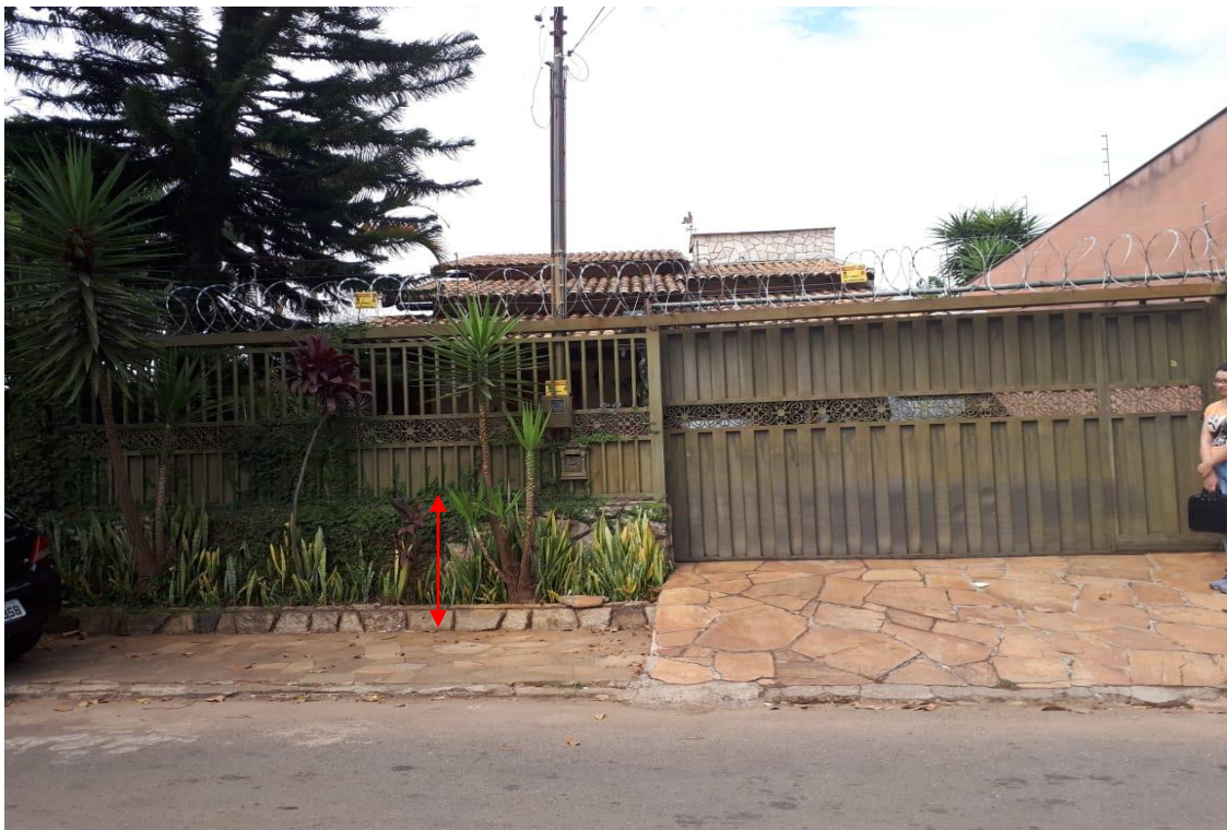
Figura 28 – Terreno com nível da edificação acima do nível da calçada
