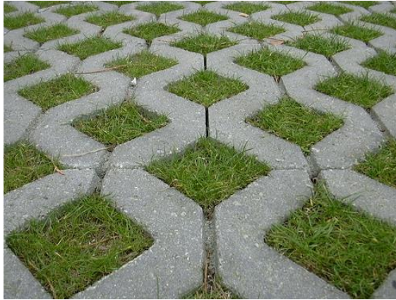
Figura 12 – Pavimento permeável como exemplo de Contenção na Fonte
