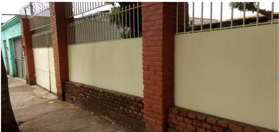
Figura 31 – Comporta de contenção
