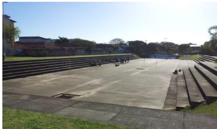
Figura 48 – Reservatório de detenção temporário, utilizado quando seco como área de lazer.
