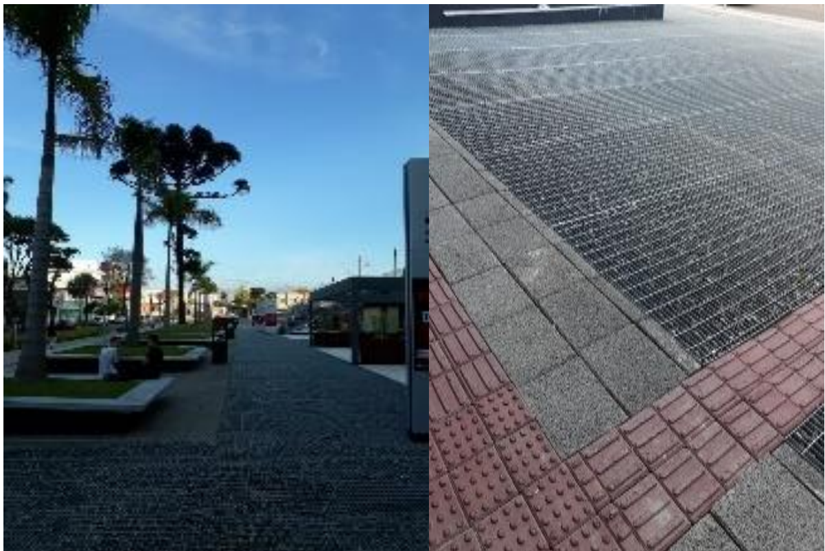
Figura 47 – Revitalização de praças com permeabilidade total em Curitiba, respeitando a acessibilidade de cadeirantes
