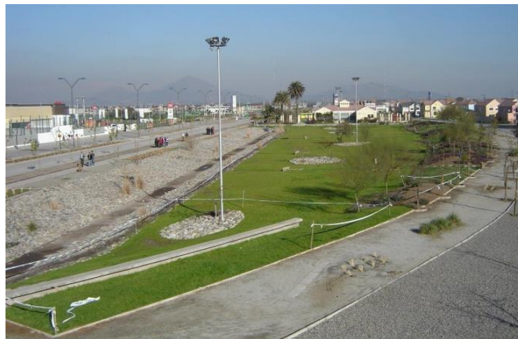
Figura 16 – Bacia de detenção em Santiago, Chile.
