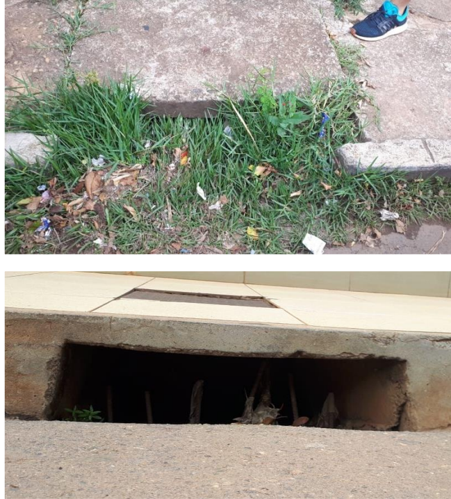
Figura 41 – Boca de loba do tipo lateral
