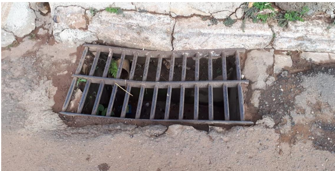
Figura 40 – Boca coletora do tipo simples com grelha
