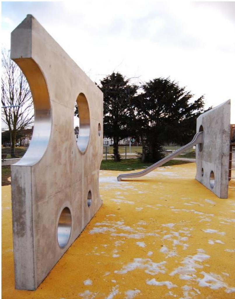
Estrutura do escorregador feita de concreto e escorregador feita de chapa metálica
