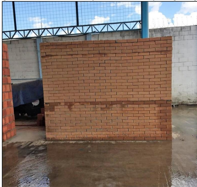
Figura 23- Assentamento dos tijolos durante execução de protótipo.
