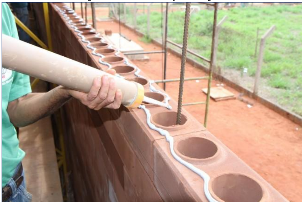
Figura 2– Assentamento de tijolos ecológicos
