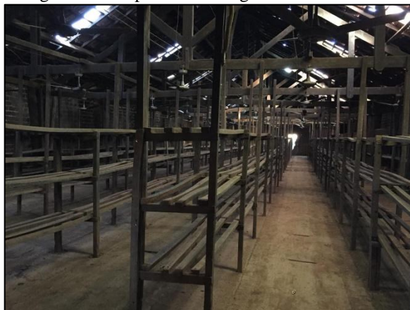
Figura 19 - Depósito de secagem com ventilador.
