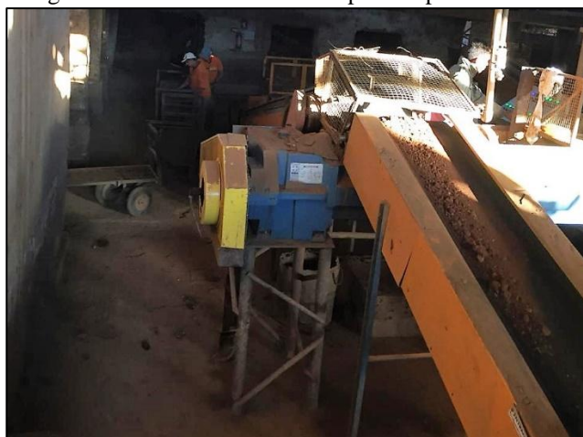
Figura 16 - Misturador utilizado pelo empreendimento.
