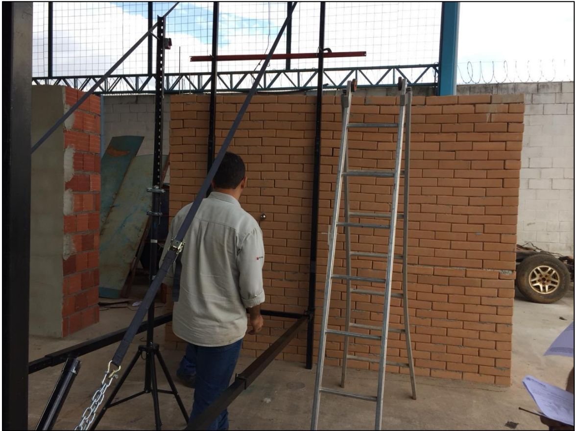
Figura 24 - Execução do teste de corpo duro.
