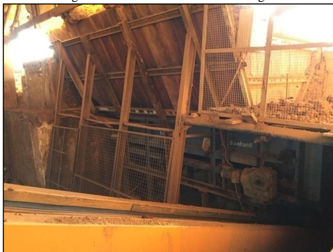
Figura 13 - Caixão alimentador de argila
