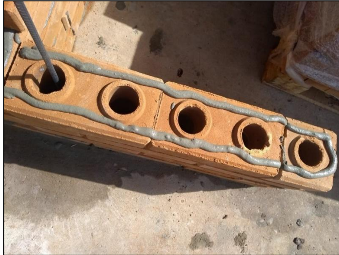
Figura 22- Assentamento dos tijolos durante execução de protótipo.
