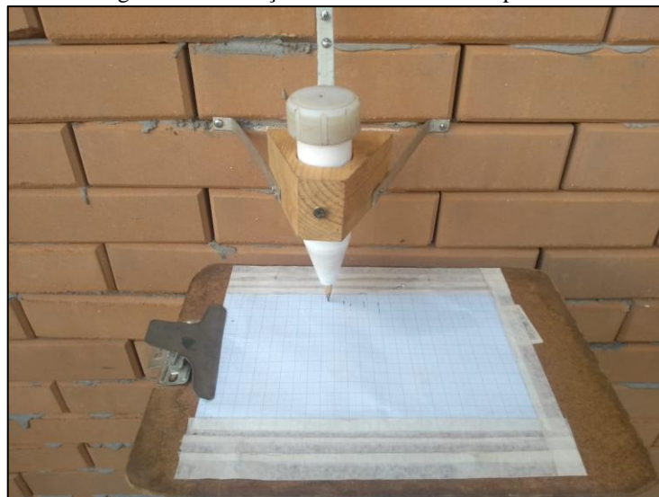
Figura 26 - Detecção do deslocamento da parede.
