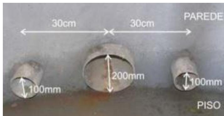
Foto 6- Sistema da utilização de dutos enterrados no Protótipo Ventura
