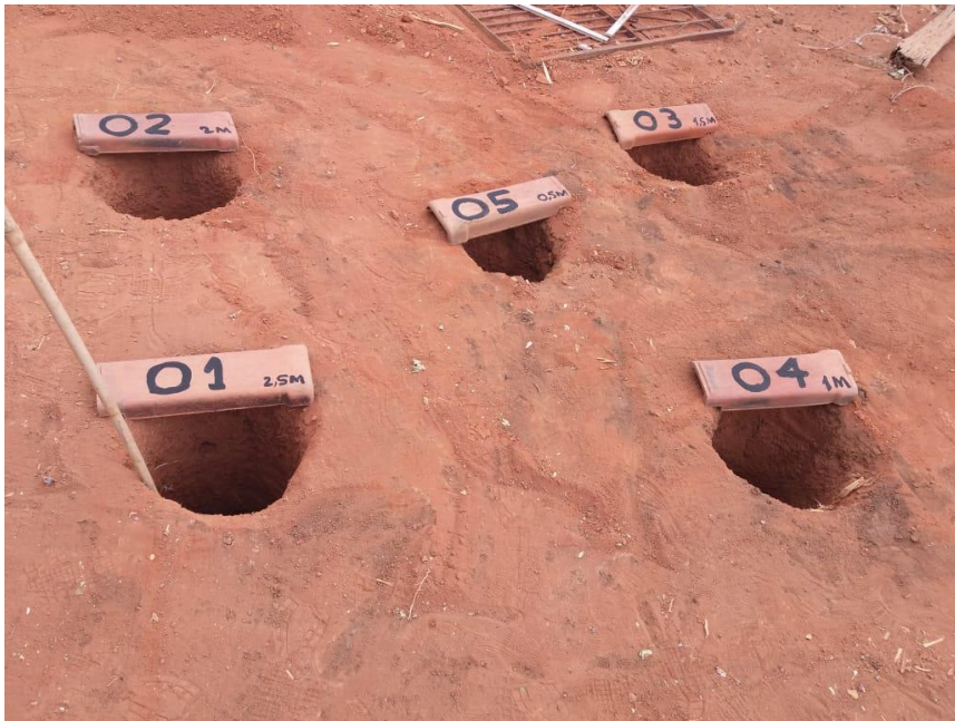
Foto 8- Furos para aferição de temperatura
