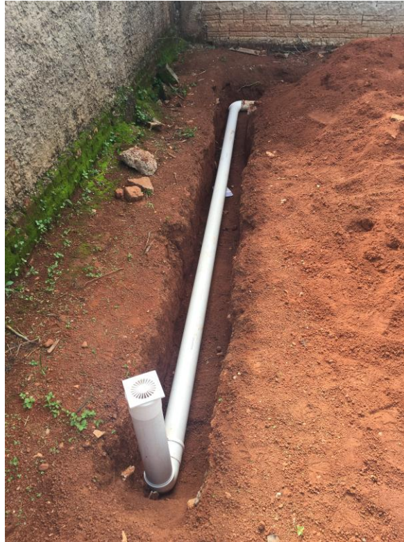
Foto 7 – Trincheira e tubulação
