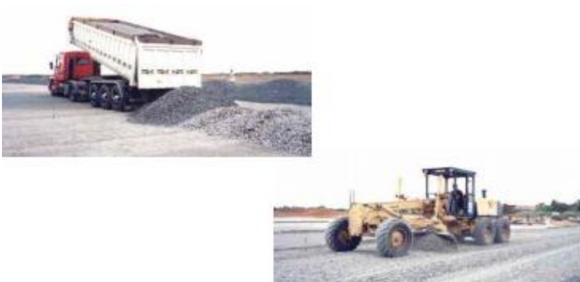
Figura 11 - Execução da base do pavimento
