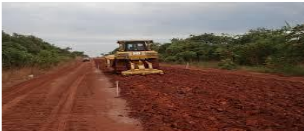
Figura 8 - Execução de subleito
