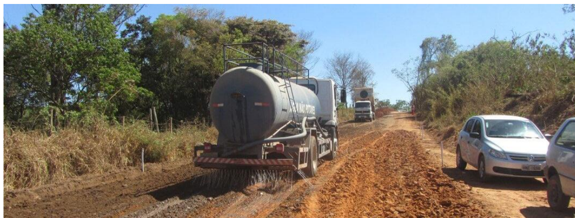
Figura 9 - Execução do reforço do subleito
