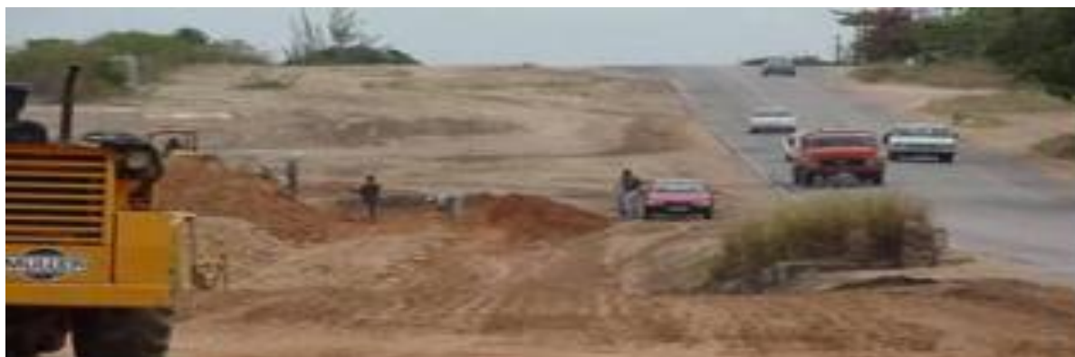
Figura 10 - Execução da sub-base do pavimento
