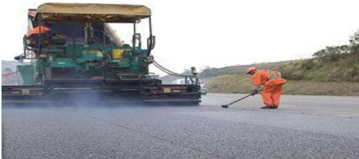
Figura 12 - Execução do revestimento de base asfáltica
