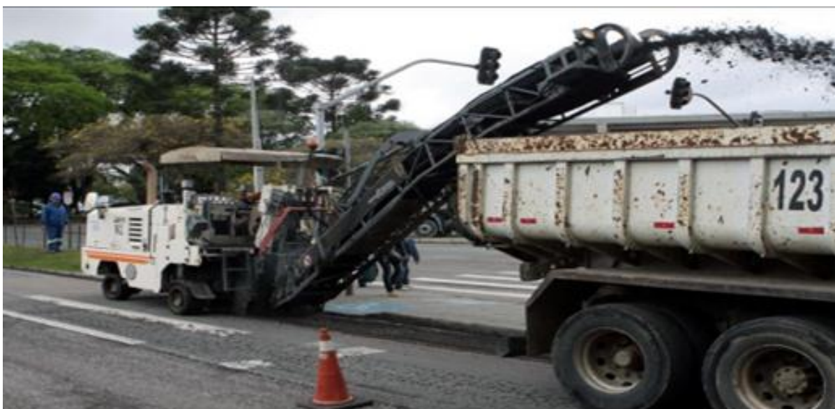
Figura 14 - Utilização do método da fresagem em obra de recuperação de pavimento
