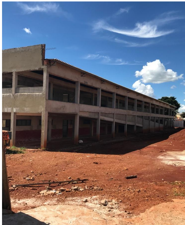
Figura 11 – Obra na Escola Raymundo Hargreaves
