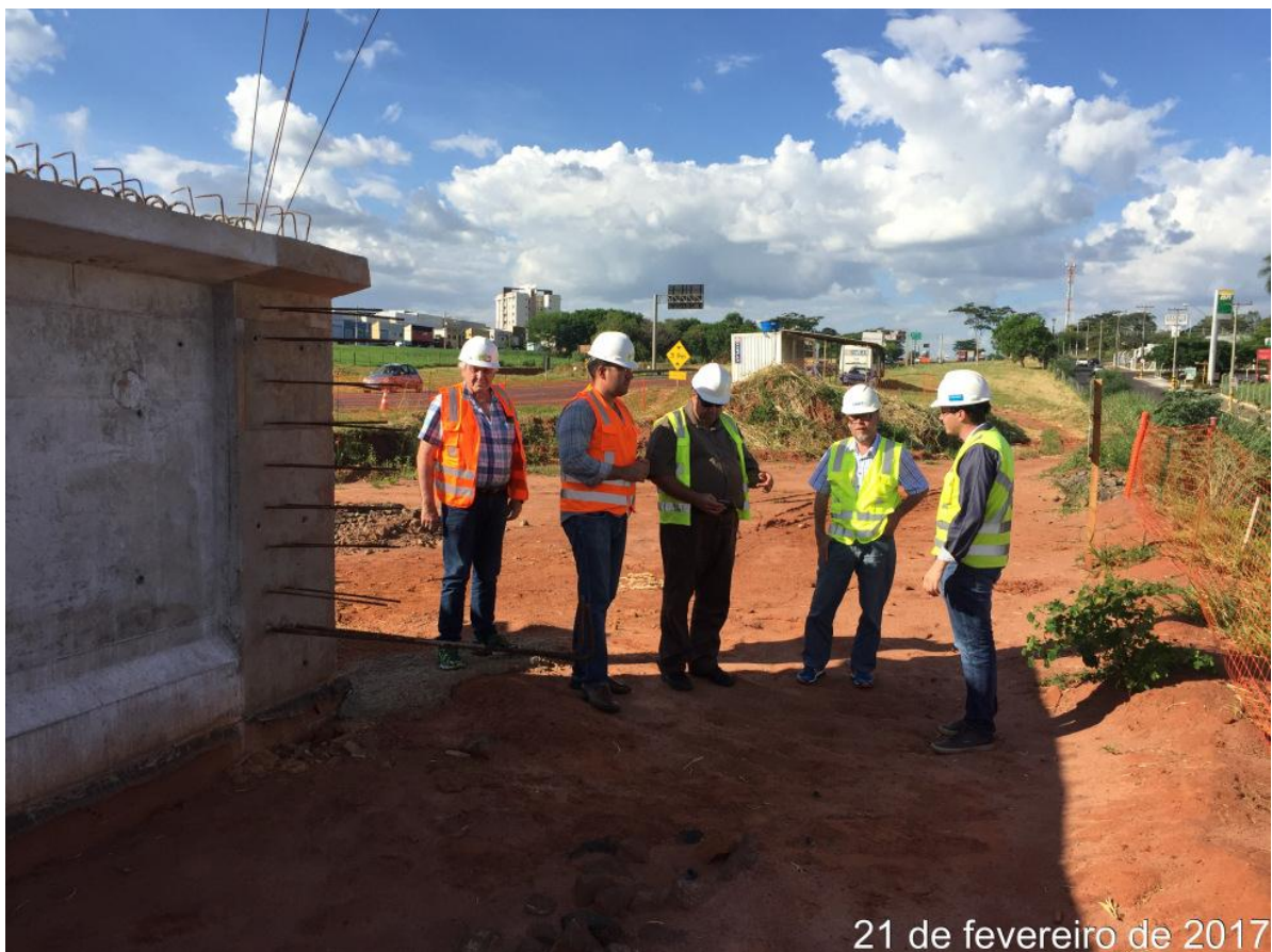
Figura 6 – Fiscais atuando em Obra da BR-153
