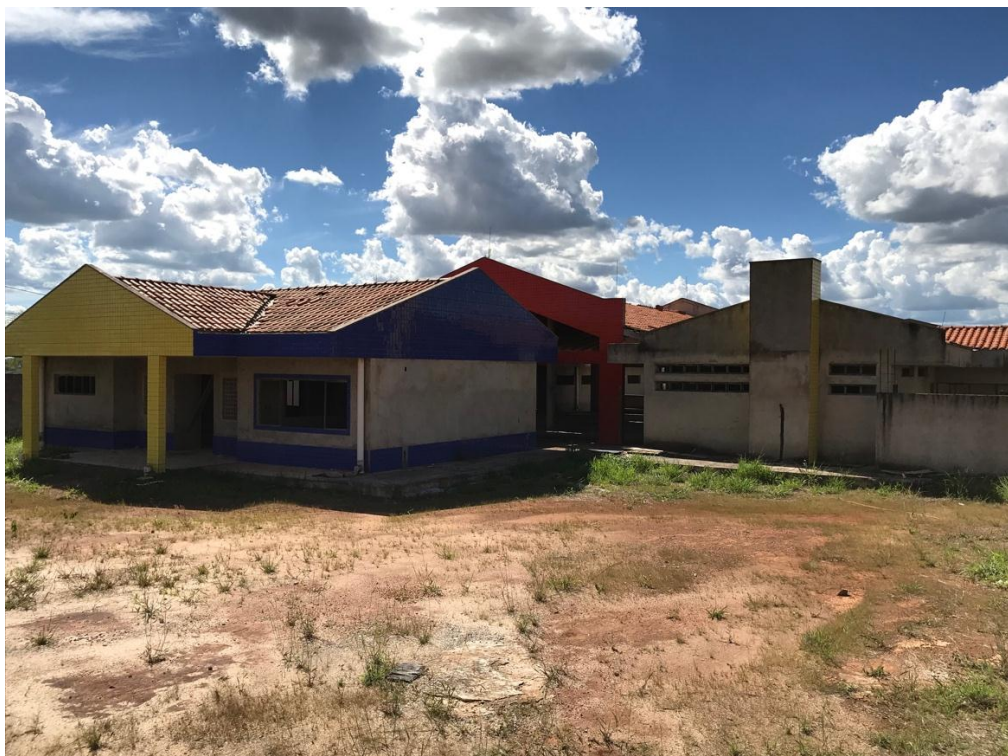
Figura 10 – Estado atual da obra na creche
