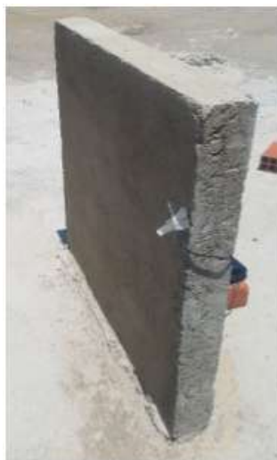
Figura 11 – Sensor DS18B20 aplicado na parede
