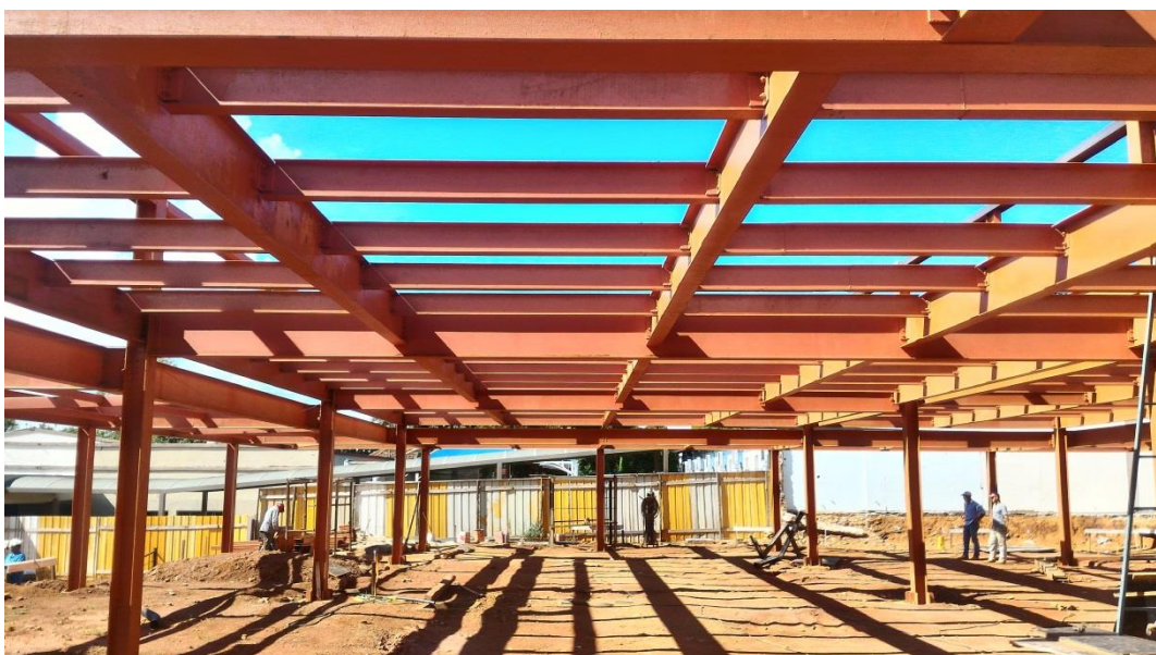
Figura 3 - Tramos da estrutura do edifício-exemplo
