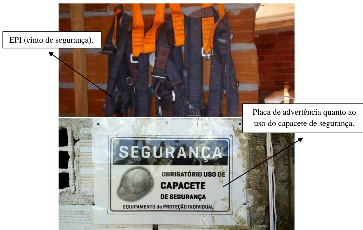
Figura 14 - Manutenção da segurança no canteiro da obra 2.
