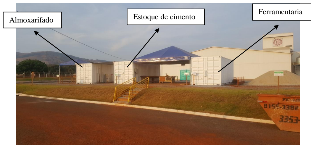
Figura 7 - Instalação provisória em containers do canteiro da obra 1.
