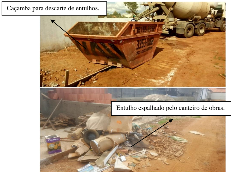
Figura 13 - Manutenção da limpeza do canteiro da obra 2.
