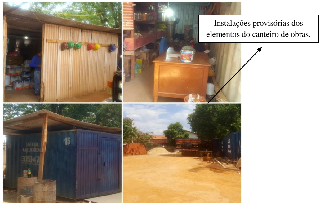
Figura 15 - Instalações Provisórias dos elementos do canteiro da obra 3.
