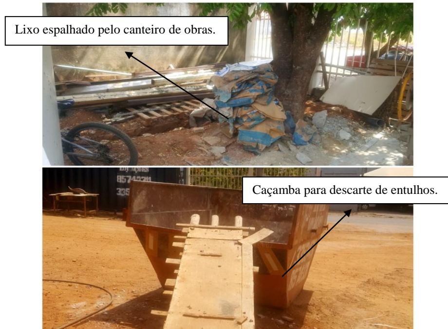
Figura 16 - Manutenção da limpeza do canteiro da obra3.
