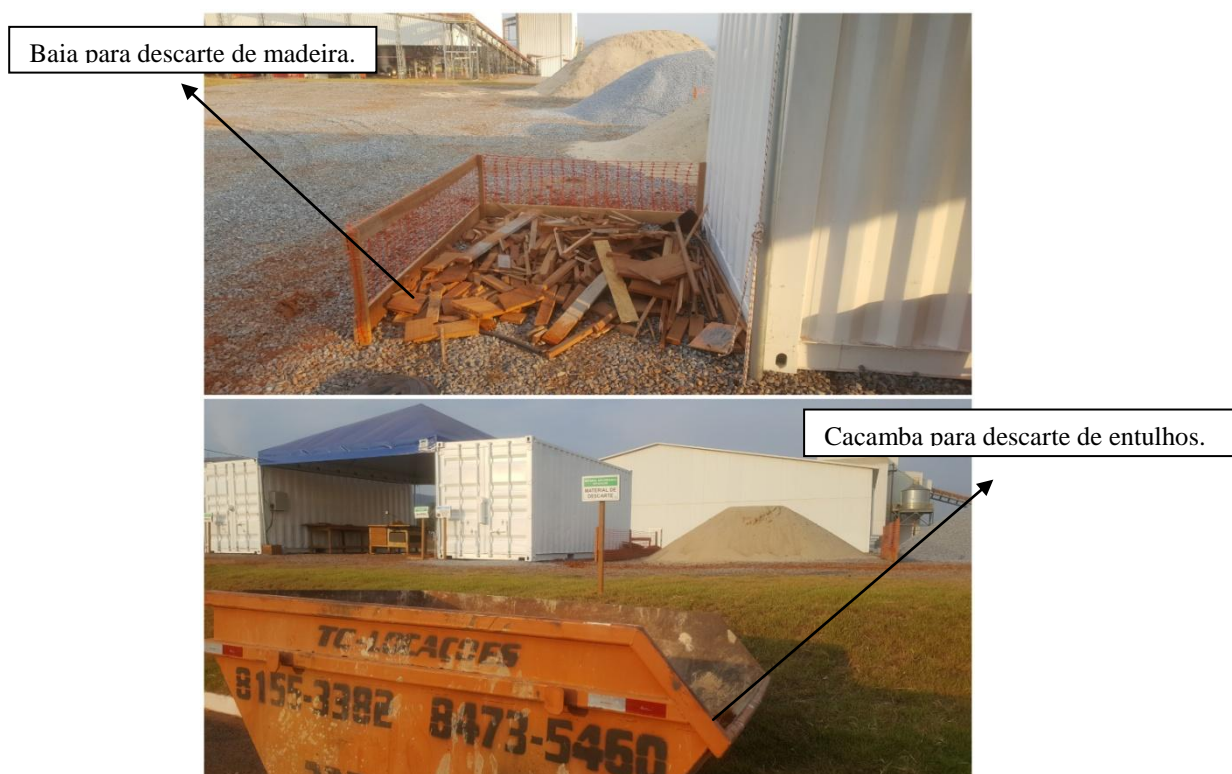
Figura 8 - Manutenção da limpeza do canteiro da obra 1.
