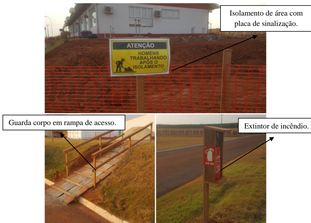
Figura 9 - Manutenção da segurança no canteiro da obra 1.
