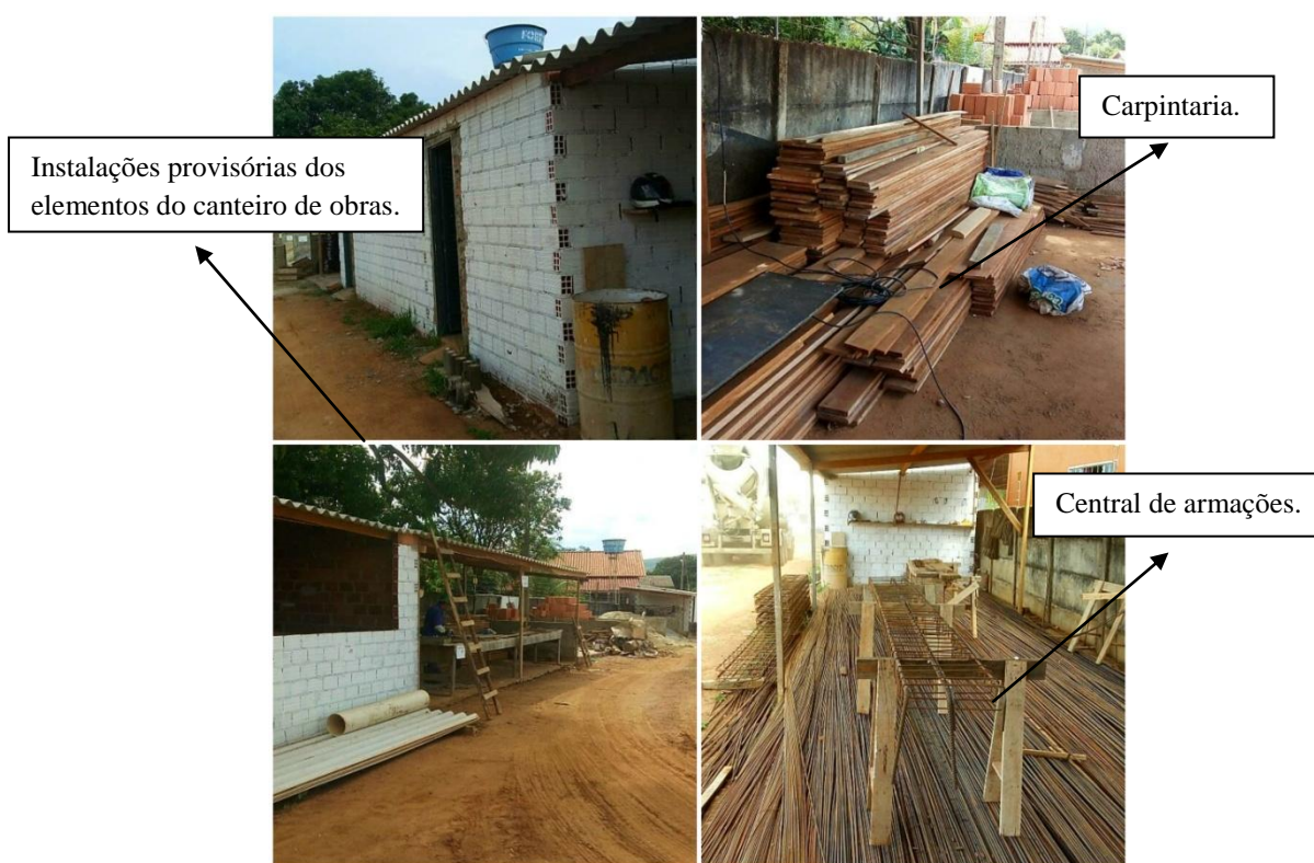
Figura 12 - Instalações provisória dos elementos do canteiro da obra 2.
