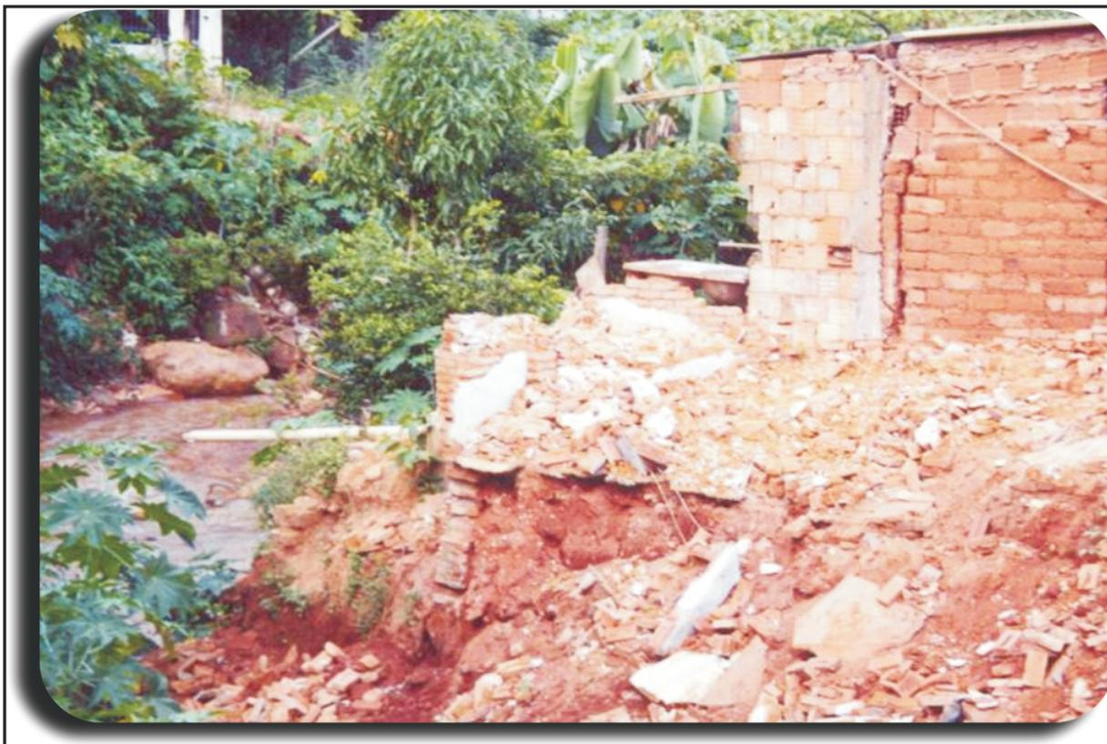
Figura nº 8 - Anápolis City - erosão e desabamento nas margens do Córrego Água Fria
