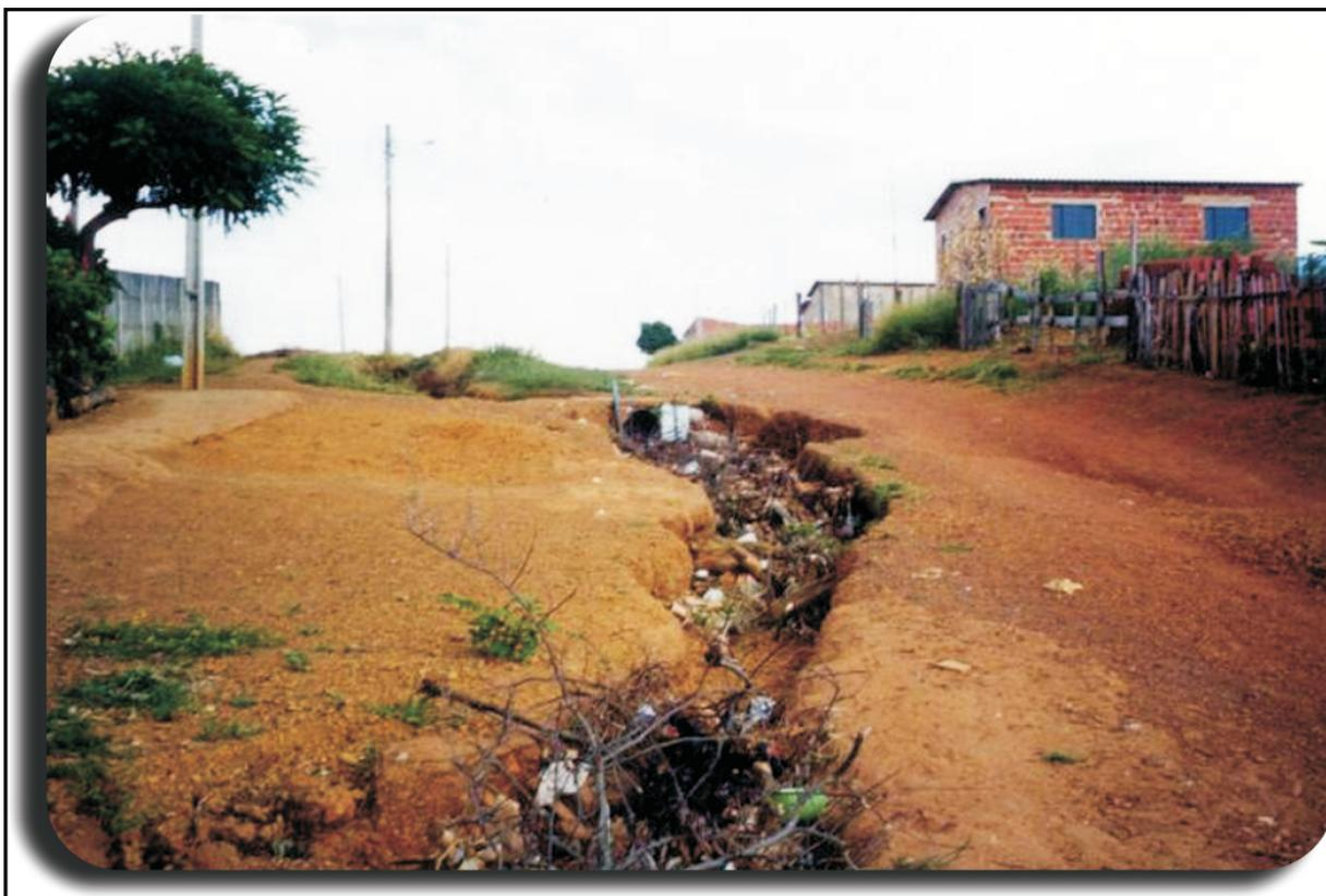
Figura n ° 7 - Voçorocas no Bairro Vivian Park decorrentes da ausência de pavimentação e drenagem
