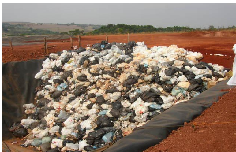
Figura 08 – Foto de uma célula de RSSS sem cerca de proteção, sem placas de sinalização, sem cobertura em lona e, ainda sem cobertura das camadas de resíduos com argila. Observa-se lixo comum em grande quantidade misturada aos RSSS.
