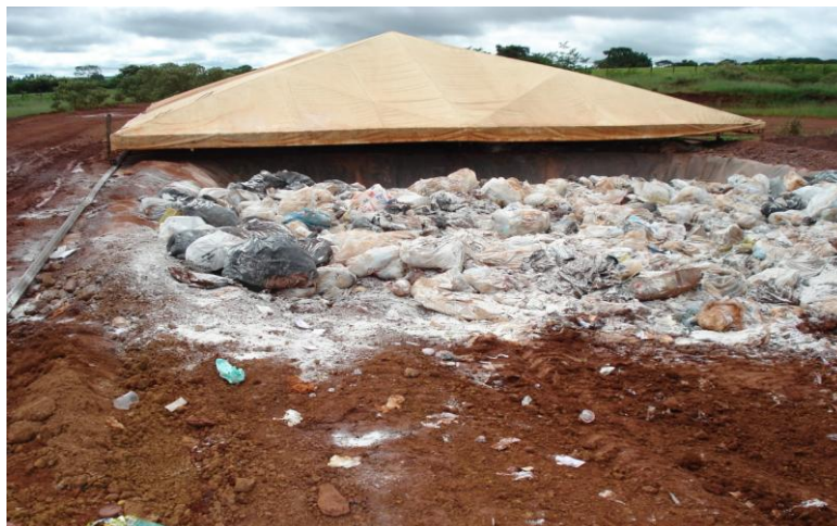
Figura 07 – Foto de uma célula de RSSS sem cerca de proteção e placas de sinalização, porém com cobertura em lona.
