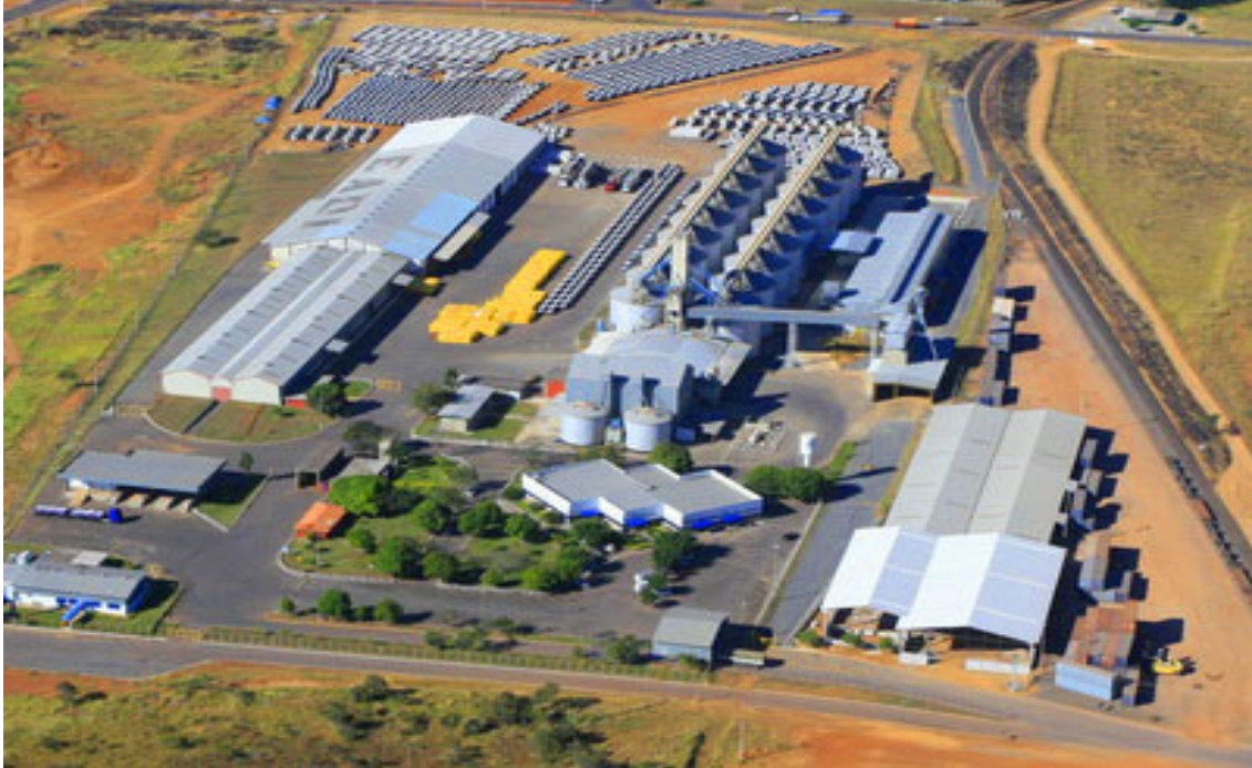
Figura 10 – Foto aérea do Porto Seco, Anápolis-Go.
