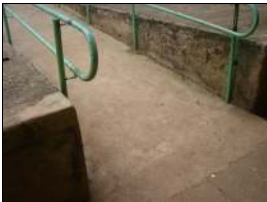
Figura 26: Adequações - rampa com corrimão. Figura 27: Adequações - escada com corrimão e guarda-corpo. (Arquivo pessoal, 2009)
