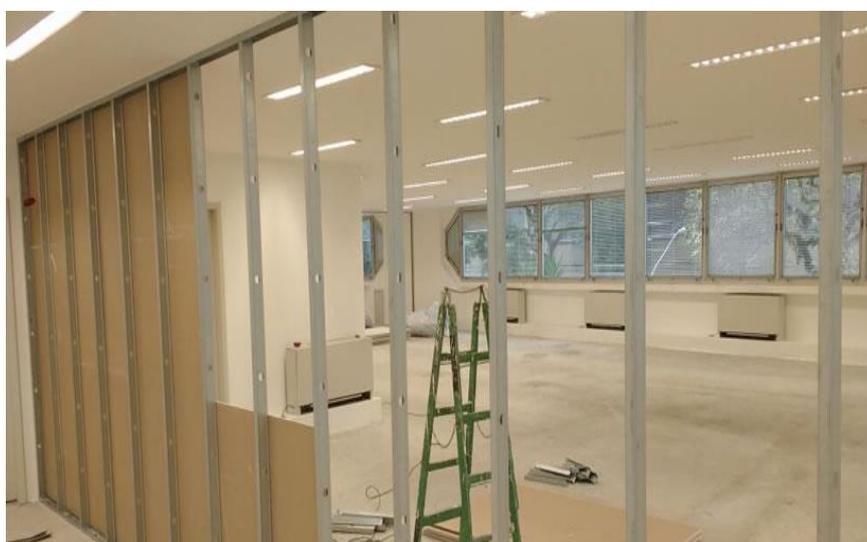
Figura 7 - Estrutura para paredes de drywall. Fonte: <http://instaplac.com.br/servicos/instalacao/paredes-drywall/>
