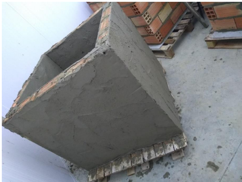
Figura16: Casa Testemunha já sendo rebocada.
