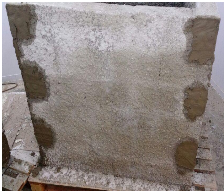
Figura21: Casa teste 3 já com chapisco para receber reboco.
