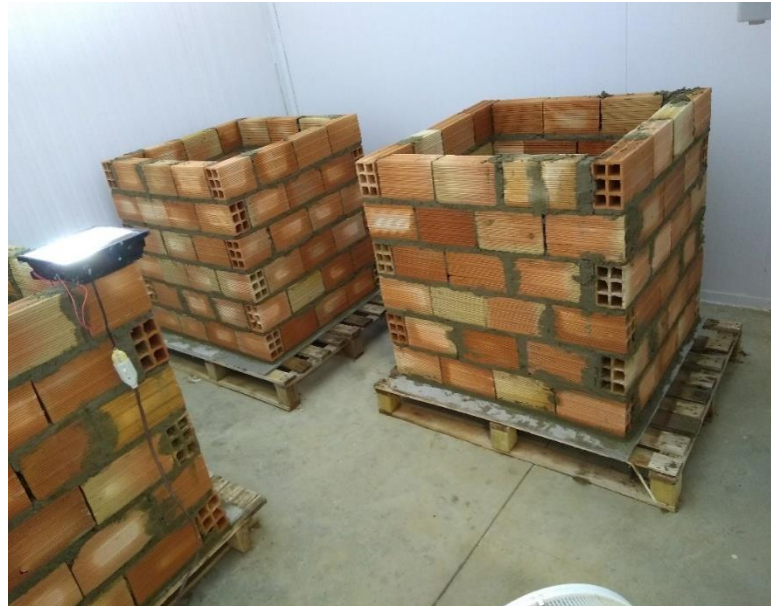
Figura 15: Alvenaria levantada pronta para receber os impermeabilizantes.
