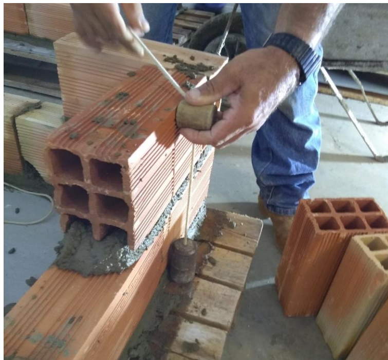
Figura 14: Levantamento da Alvenaria já Sendo Aprumada
