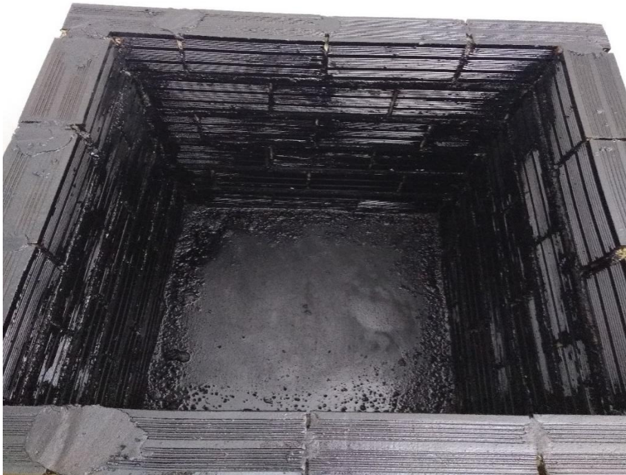
Figura19: Casa 2 já totalmente impermeabilizada com 2 demãos de impermeabilizantes Neutrol,
