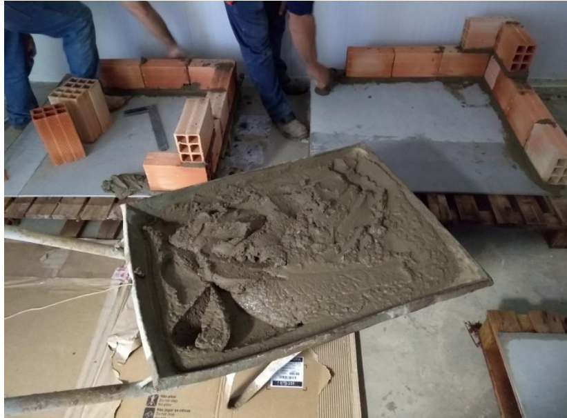
Figura13: Traço 3x1 para levantamento de parede.
