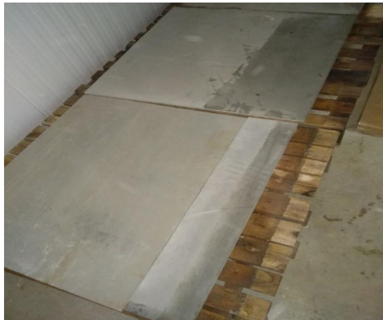
Figura 12: Placas Cimentíssimas em cima dos Palites dentro da Câmara Úmida.
