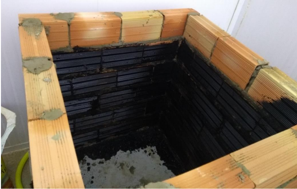
Figura18: Casa 2 já recebendo a primeira mão do impermeabilizante Neutrol.
