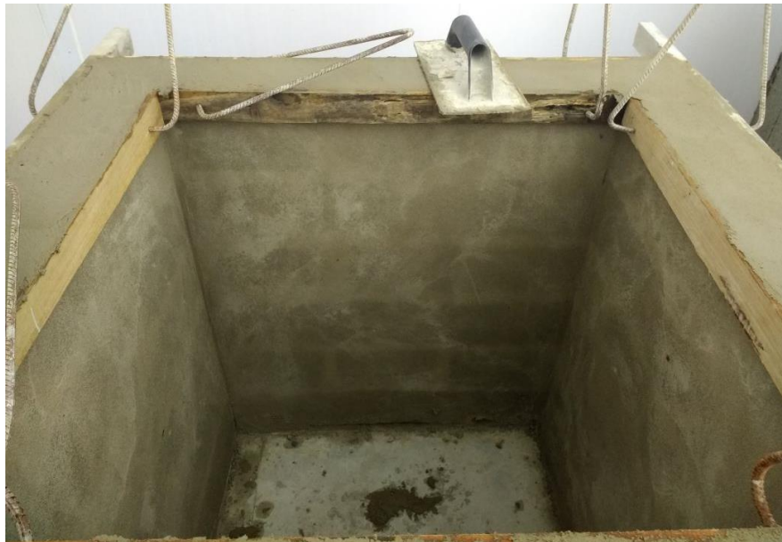
Figura23: Gancho para fazer requadro.
