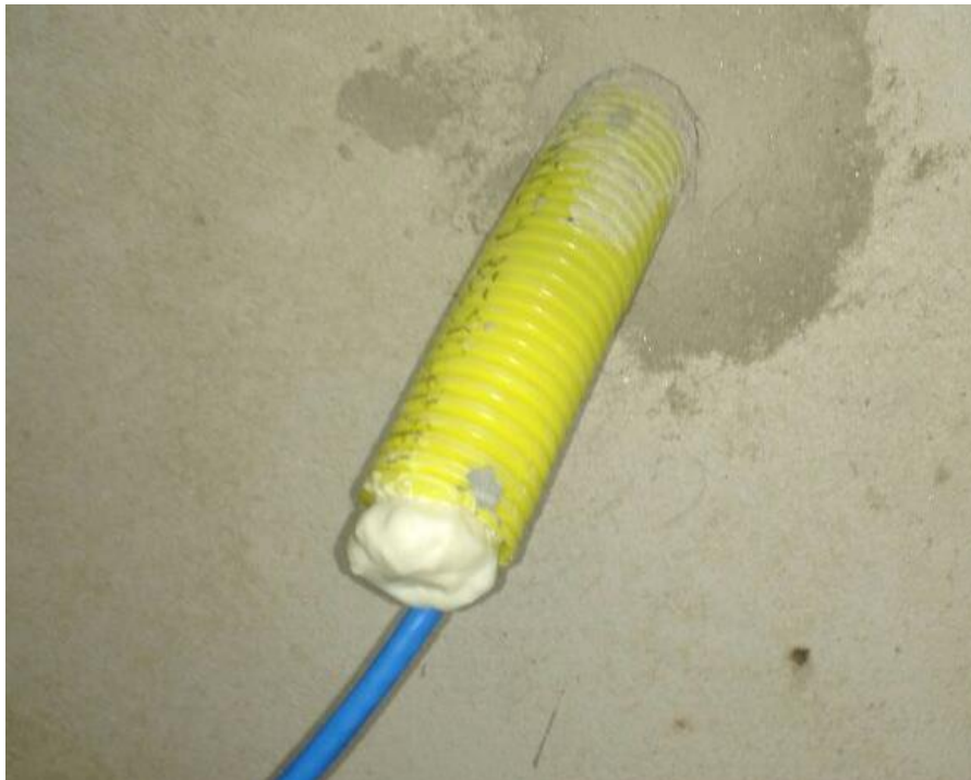
Figura 29: Cabo de rede já dentro do conduíte.
