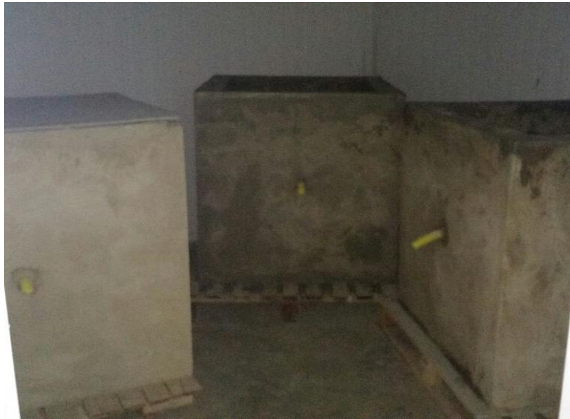
Figura24: casas testes cada uma com sua especificação já concluídas.
