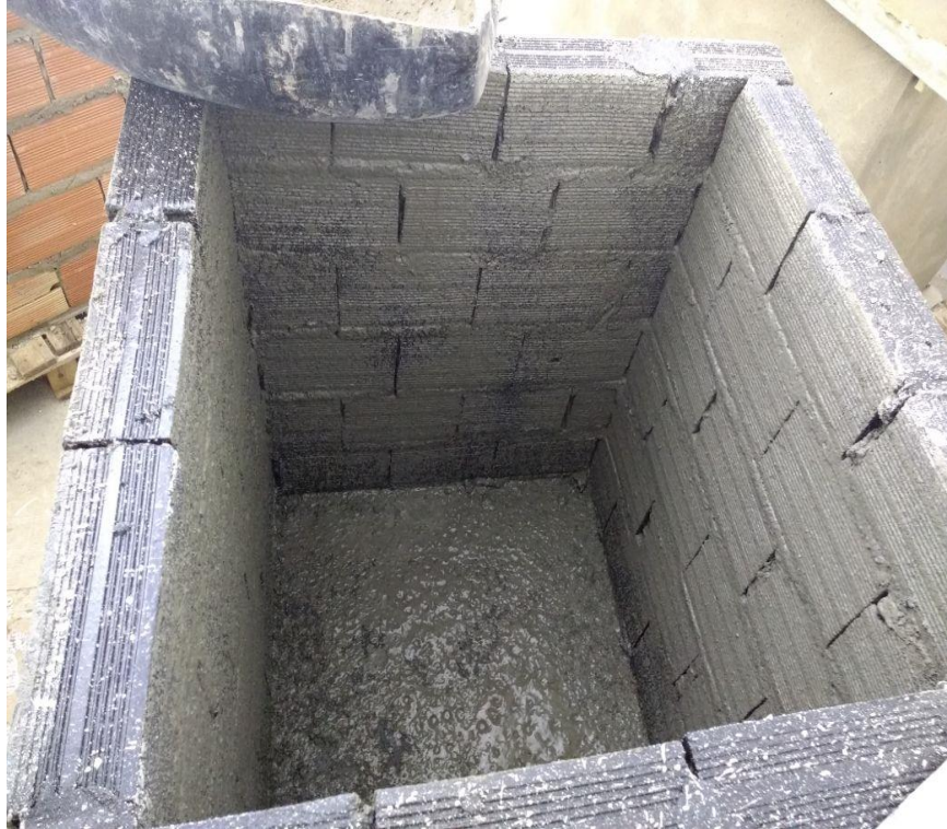
Figura22: Casa teste 2 já com chapisco para receber reboco.
