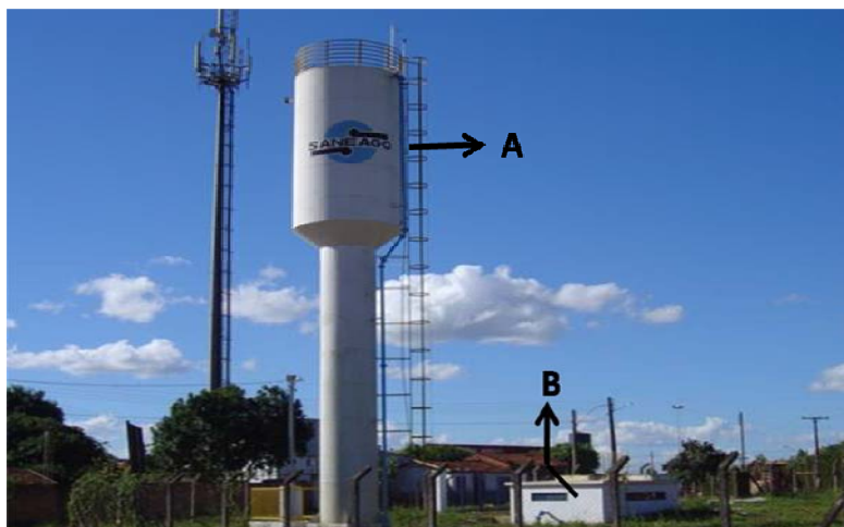
Figura 15. Caixa d'água da instalada pela Empresa Saneago S.A. para abastecimento do Filostro Machado Carneiro, Anápolis, 2011. Foto: Welton Dias Barbosa Vilar, fevereiro de 2011.
