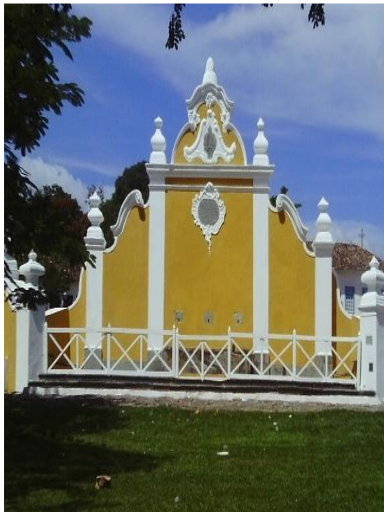
Figura 12: Chafariz de Cauda da Boa Morte Fonte: A. B. T. (2011)
