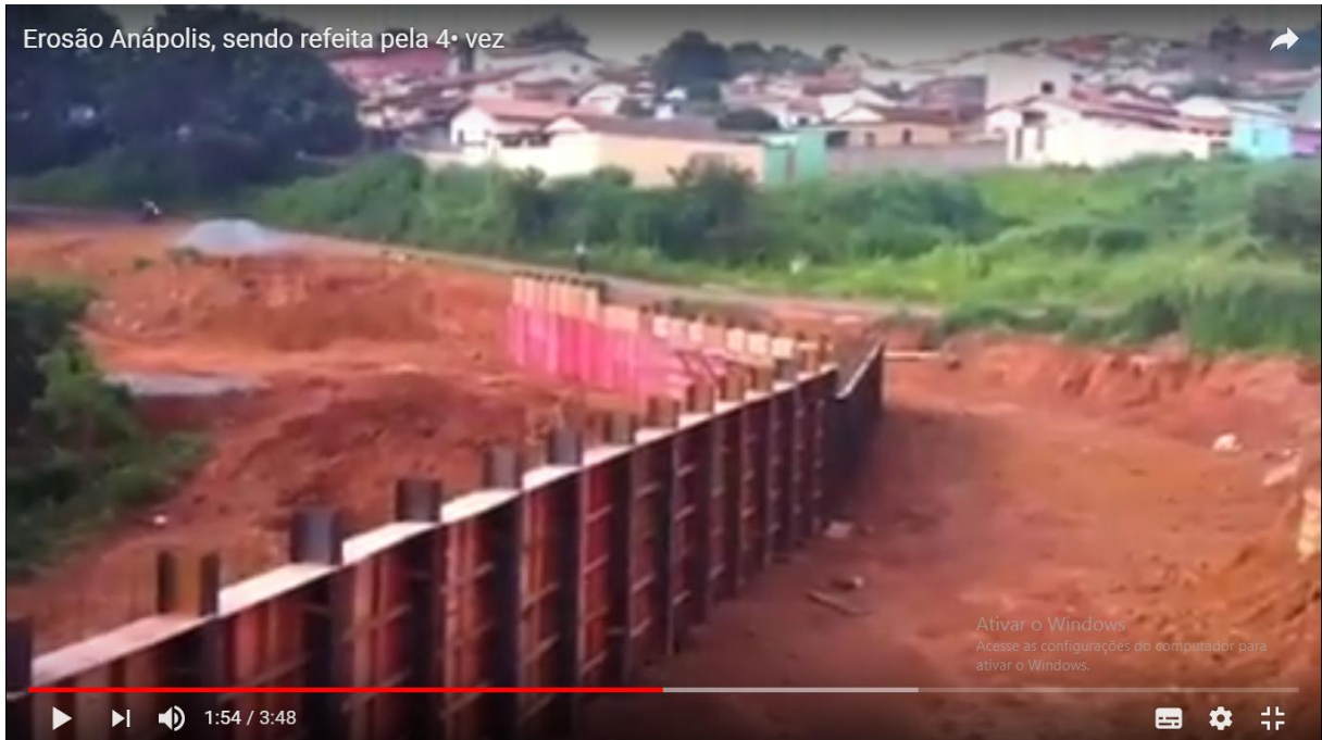
Figura 22:4ª CONSTRUÇÃO DE PAINEL DE CONCRETO-DEZ/2013
