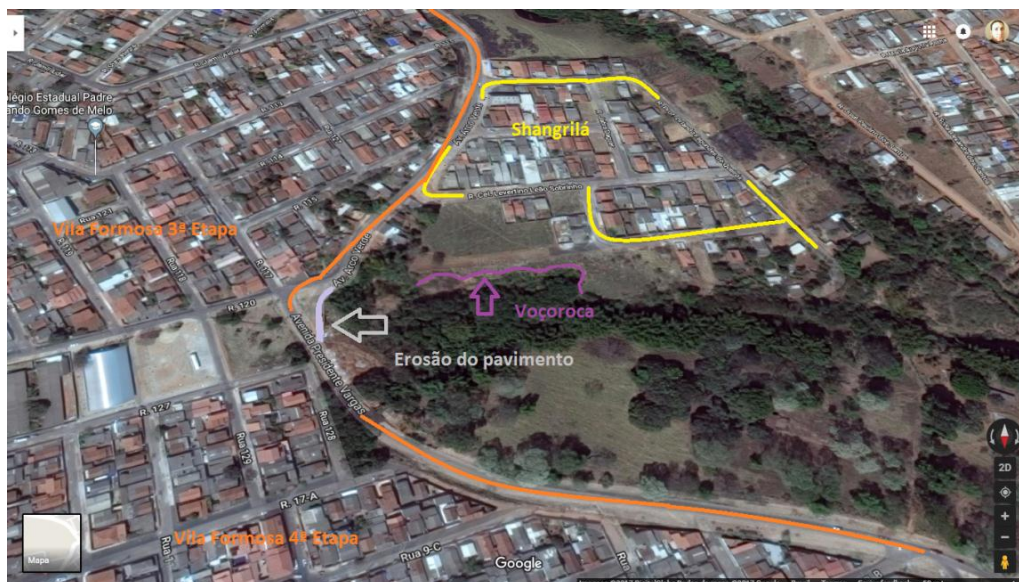
Figura 4: VISTA AÉREA DOS BAIRROS LIMÍTROFES DA EROSÃO
