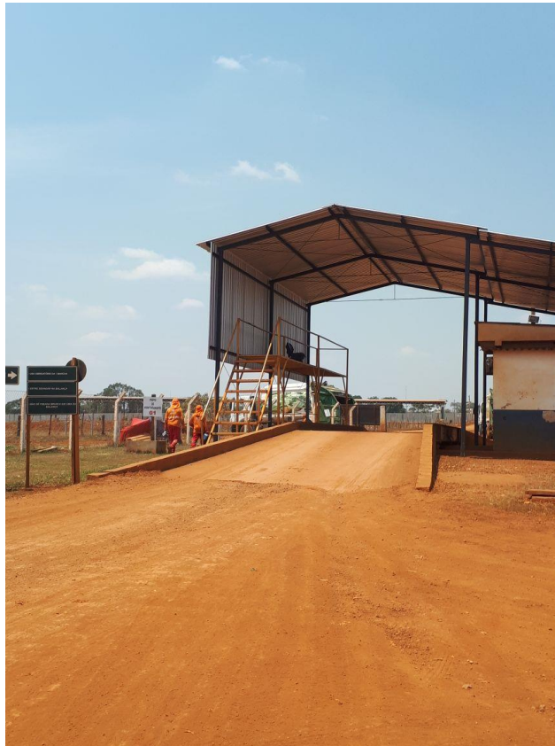
Figura 5 - Entrada do aterro com balança para a quantificação de resíduos.
