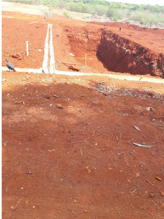
Figura 6 – Trincheiras abertas para a disposição de resíduos.
