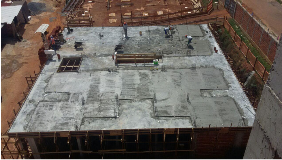
Figura 15 - Regularização do concreto
