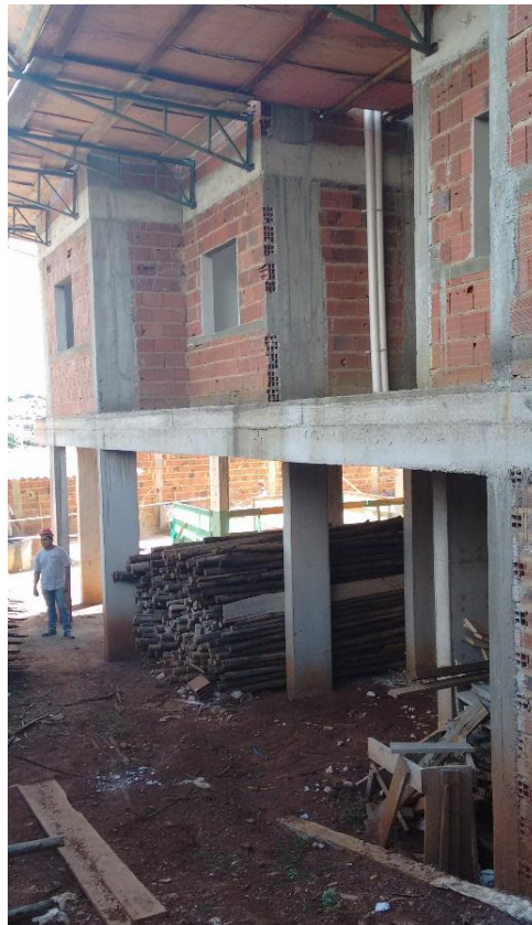
Figura 20 - Exemplo de pilares sustentando vigas
