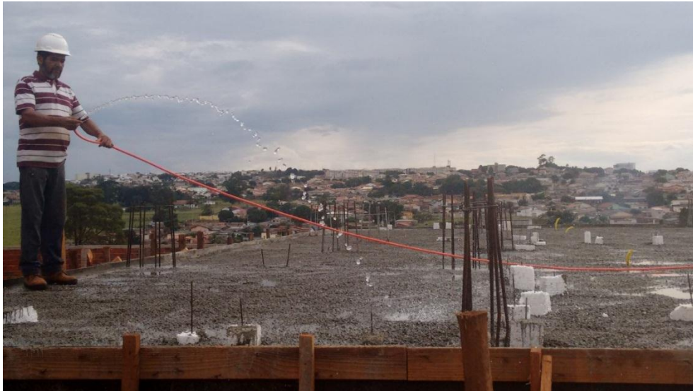
Figura 16 - Umidificação do concreto
