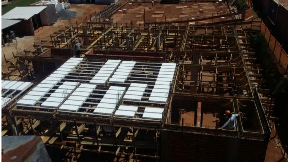
Figura 13 - Sobreposição dos blocos de EPS sobre entre as vigotas.
