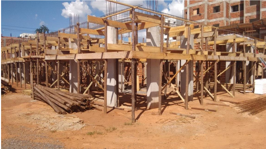
Figura 18 - Vigas ligando os pilares
