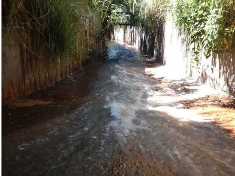
Figura 24: Trecho canalizado no rio das Antas - Anápolis
