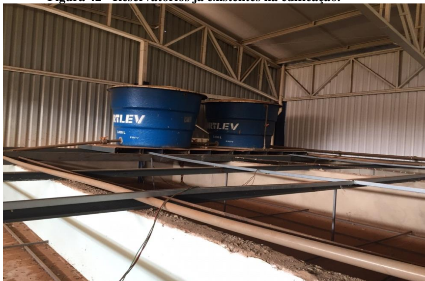
Figura 42 - Reservatórios já existentes na edificação.
