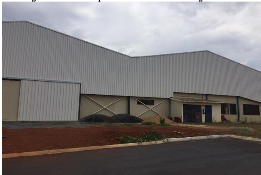
Figura 41 - Fachada posterior do Centro Tecnológico
