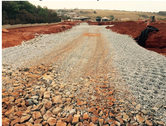
Figura 28 - Camada superior de brita
