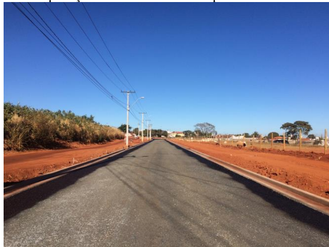
Figura 40 – Aplicação de asfalto diluído de petróleo nas bordas da pista
