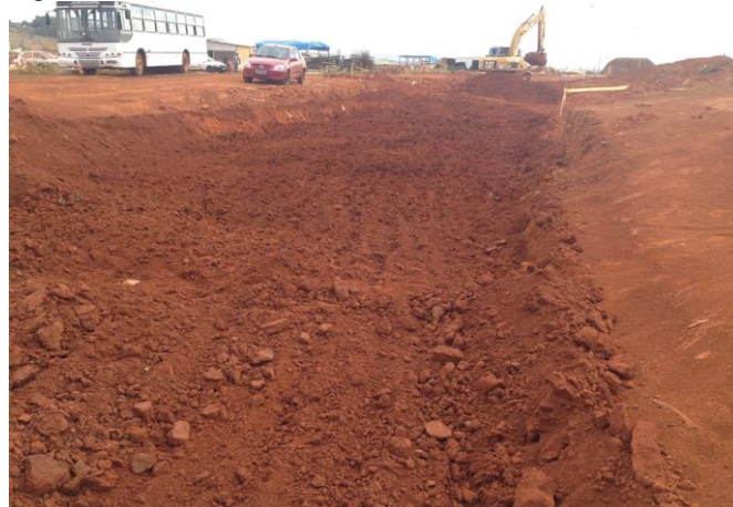
Figura 26 - Retirada dos 40 cm de material natural do subleito
