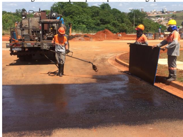
Figura 46 – Aplicação da pintura de ligação
