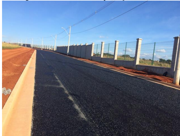
Figura 42 – Processo de imprimação concluído
