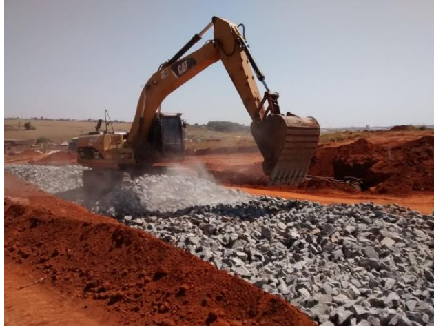
Figura 27 - Adição e compactação de rachão com escavadeira hidráulica
