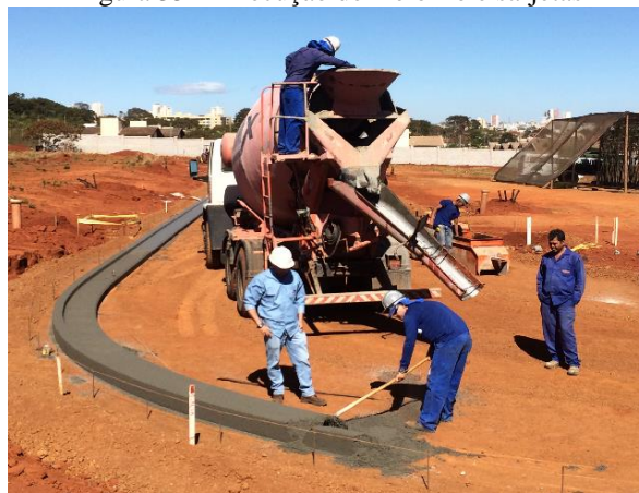
Figura 35 – Execução de meio fio e sarjetas
