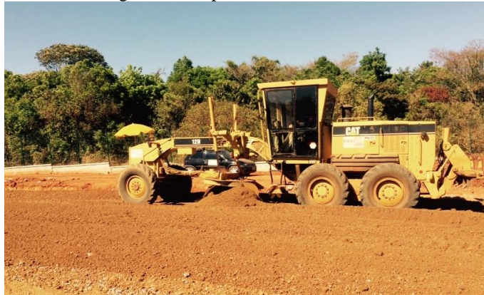
Figura 31 - Espalhamento do material
