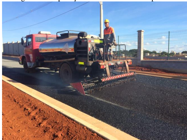
Figura 41 – Aplicação de asfalto diluído de petróleo
