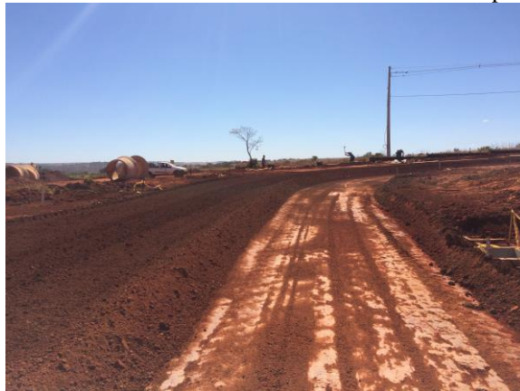
Figura 22 – Parte da camada de fundo do subleito compactado
