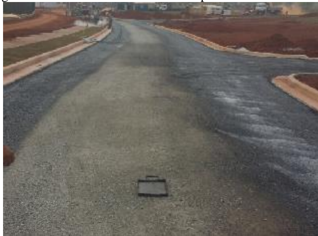
Figura 43 – Recolhimento do material para teste de taxa efetiva
