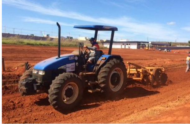
Figura 20 – Escarificação com trator agrícola com grades de disco
