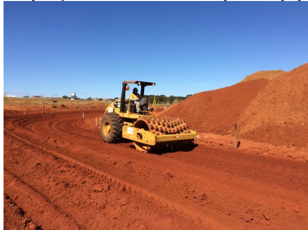
Figura 21 – Compactação do subleito com Rolo compactador tipo pé de carneiro
