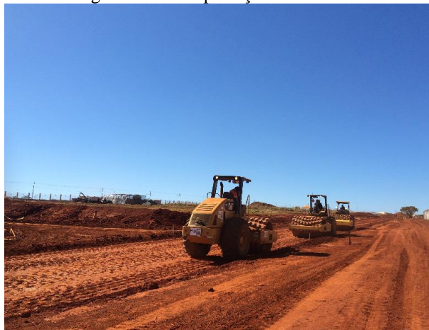
Figura 32 – Compactação da sub-base
