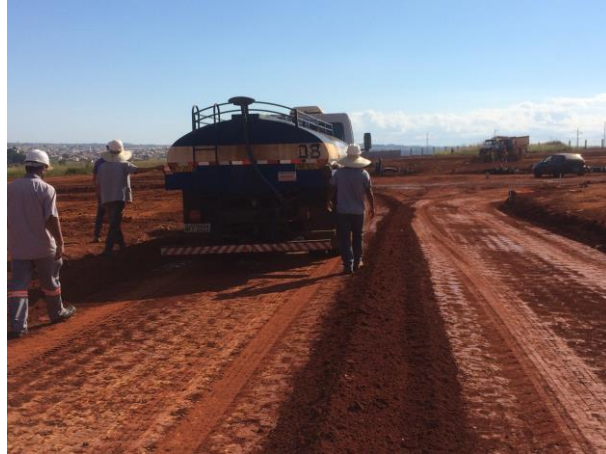
Figura 23 - Teste de carga com caminhão tanque
