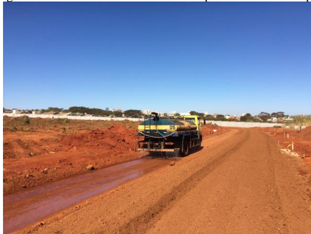
Figura 19 – Material sendo umedecido pelo caminhão tanque
