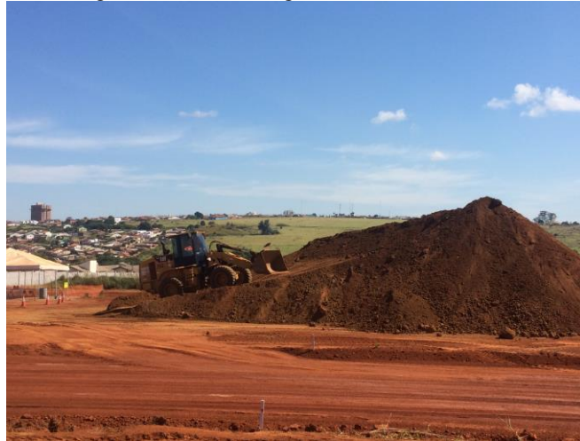
Figura 29 - Armazenagem de cascalho na obra
