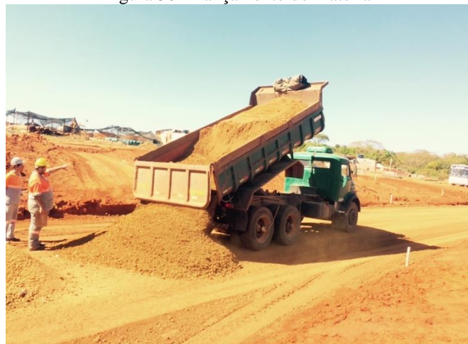
Figura 30 - Lançamento do material
