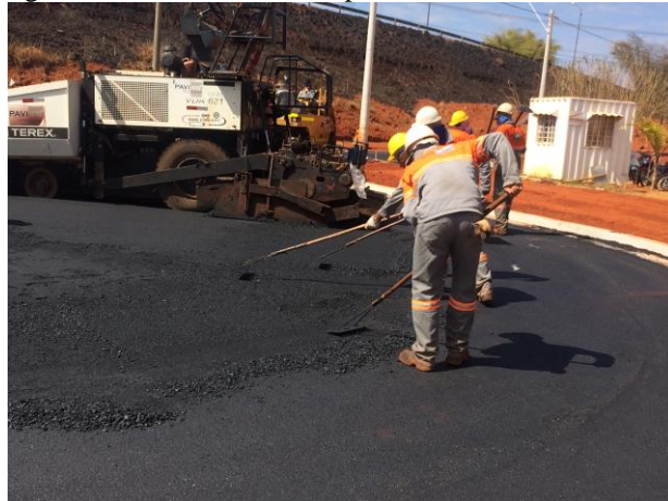
Figura 52 – Rastelo utilizado para acabamento de emendas
