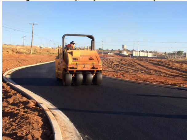
Figura 53 – Compactação com o rolo de pneus
