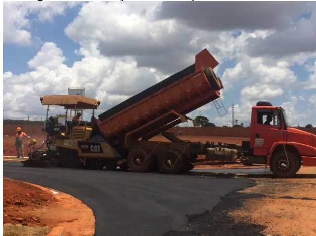
Figura 49 – Inserção de CBUQ na vibroacabadora
