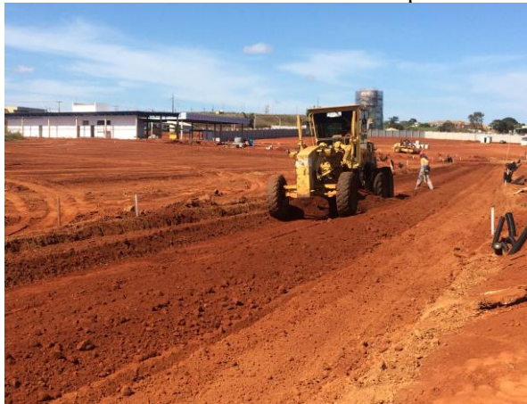
Figura 18 – Tombamento do material do subleito pela motoniveladora
