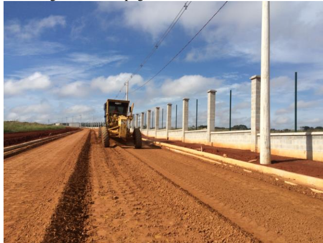
Figura 36 – Raspagem do material em excesso
