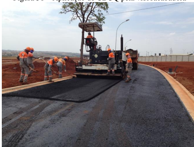
Figura 51 – Aplicação de CBUQ pela vibroacabadora
