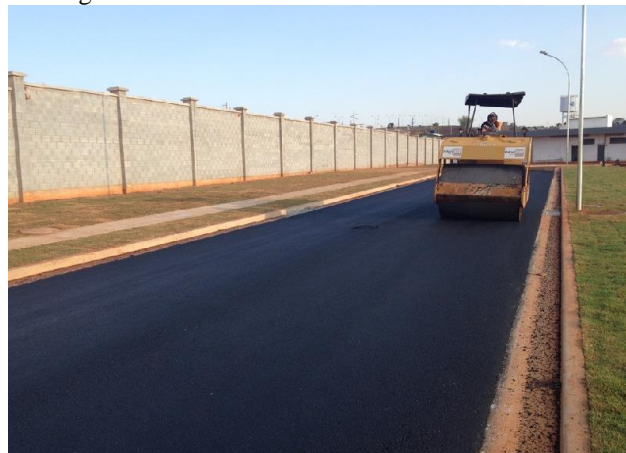
Figura 54 – Acabamento com o rolo metálico liso
