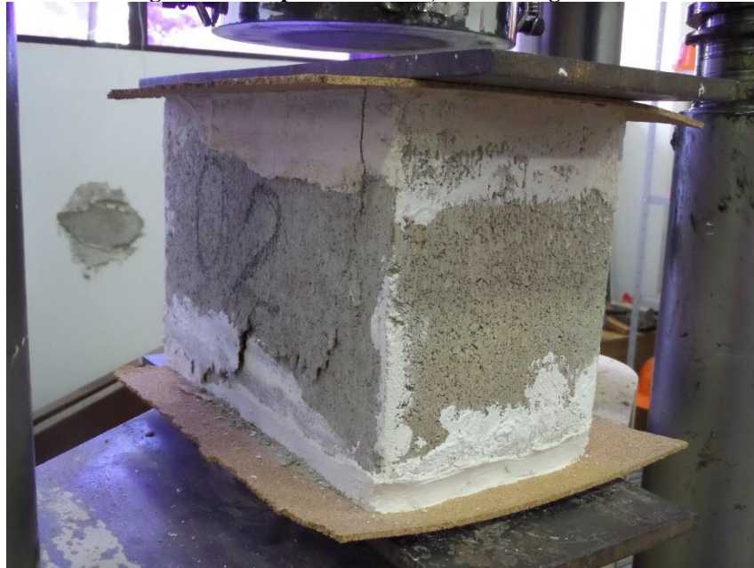
Figura 25 – Ruptura do Bloco, fissura longitudinal
