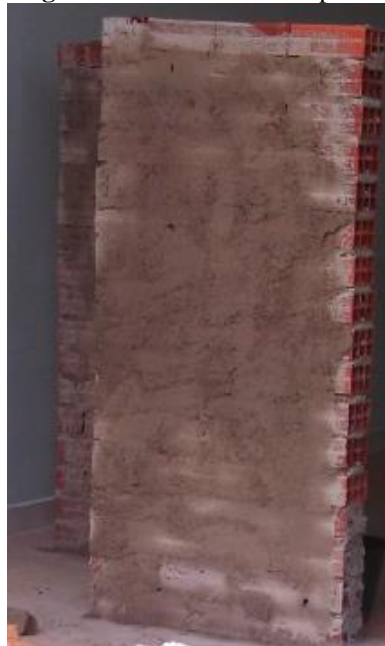
Figura 14 - Parede com chapisco.
