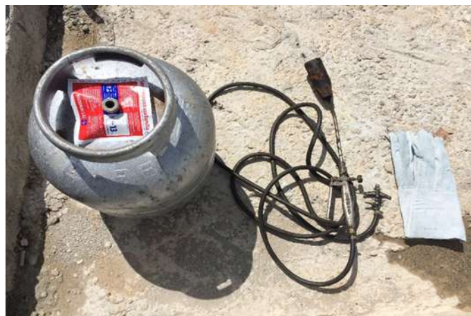
Figura 25 – Materiais utilizados para aplicação da manta asfáltica
