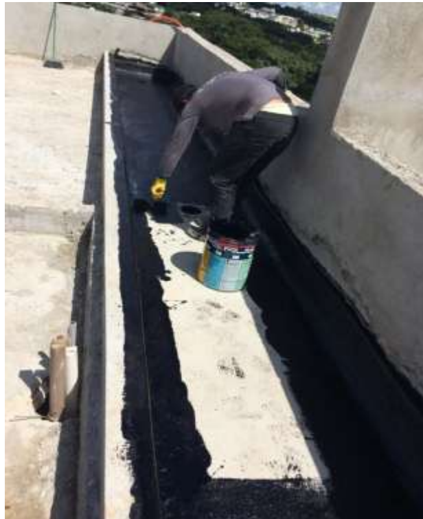
Figura 28 – Aplicação do prime
