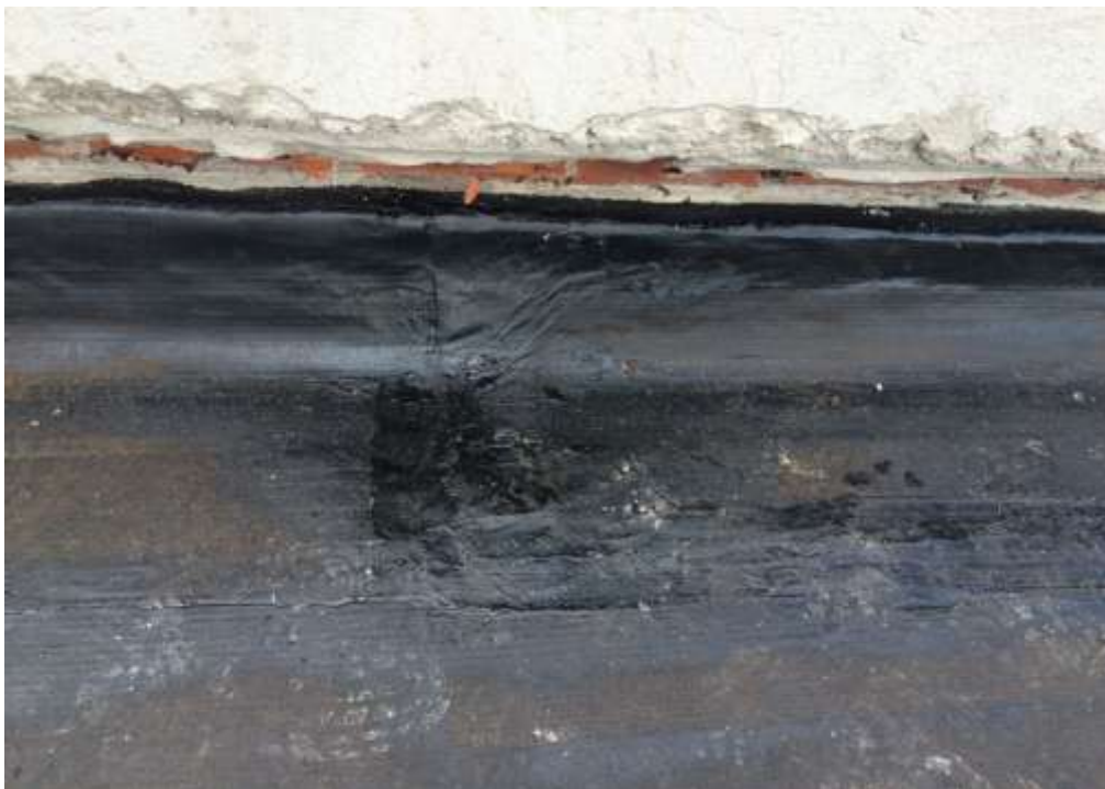
Figura 31 – A manta embutida na parede
