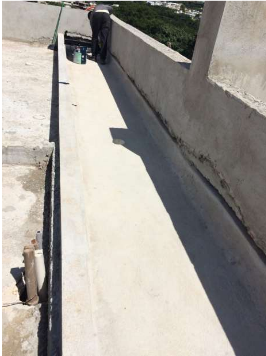
Figura 26 – Laje limpa, seca e sem qualquer deformação.
