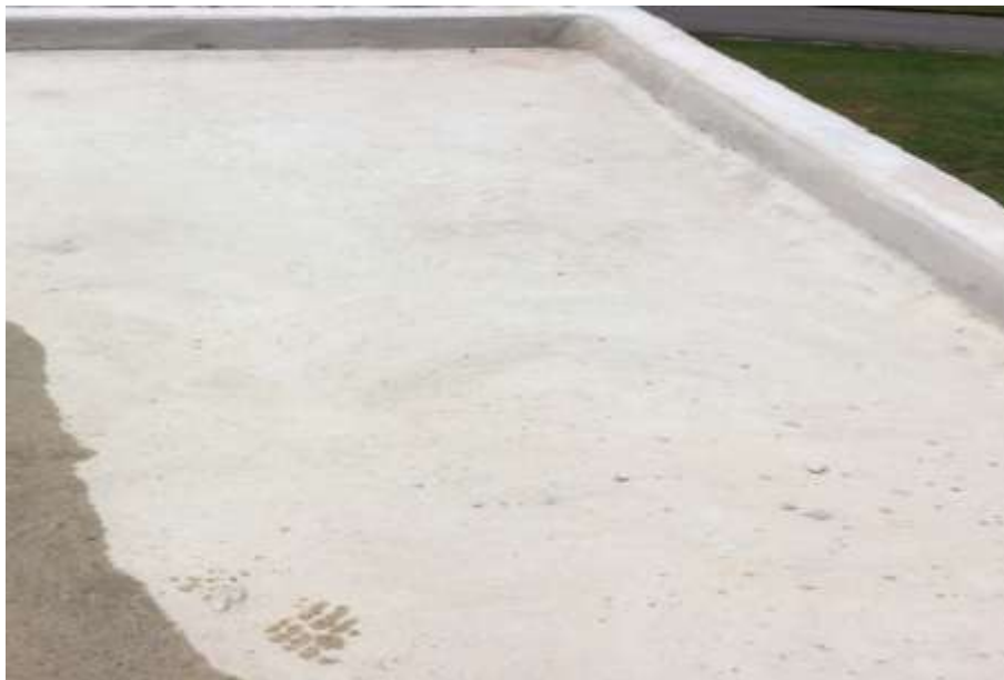
Figura 33- Proteção mecânica sobre a laje, totalmente curada.
