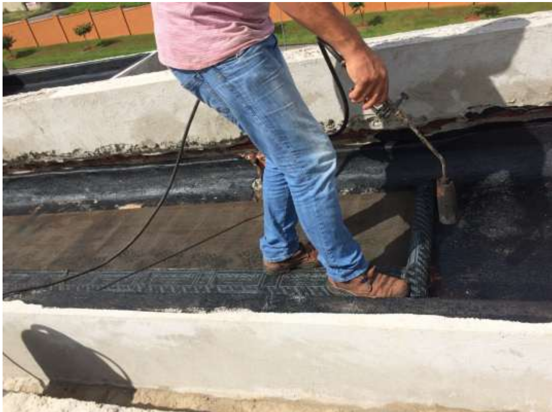
Figura 29 – Aplicação da manta asfáltica com maçarico
