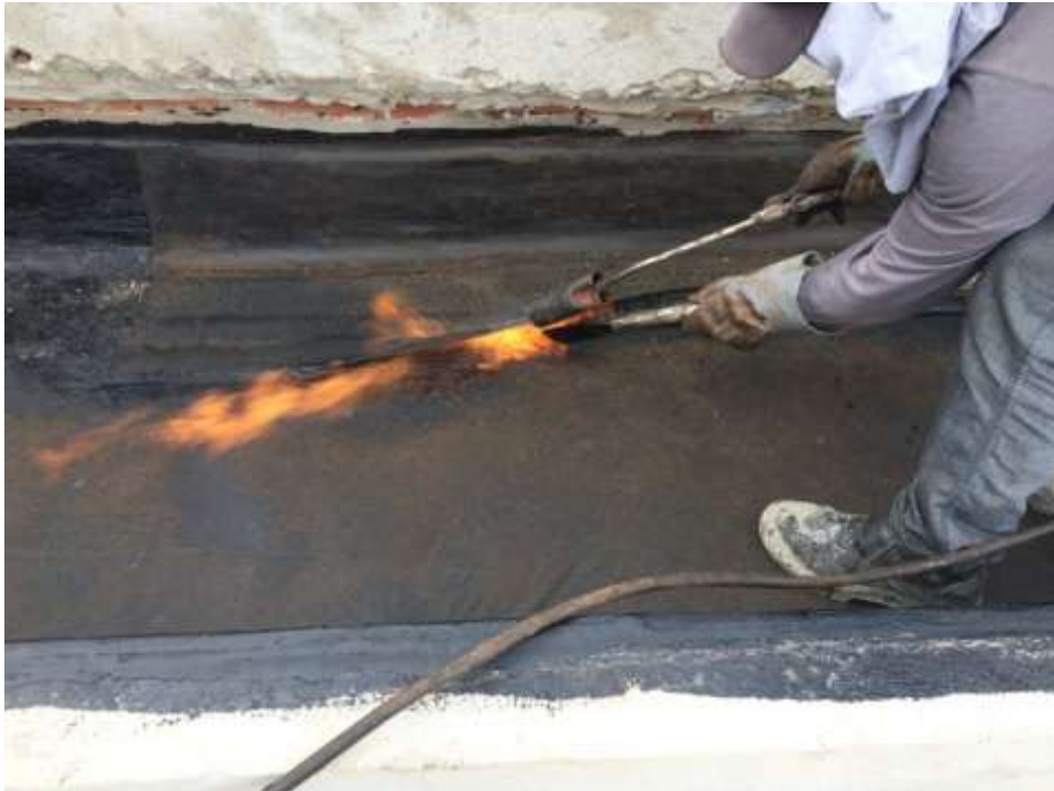
Figura 30 – Aquecimento da manta e espátula para selar a sobreposição
