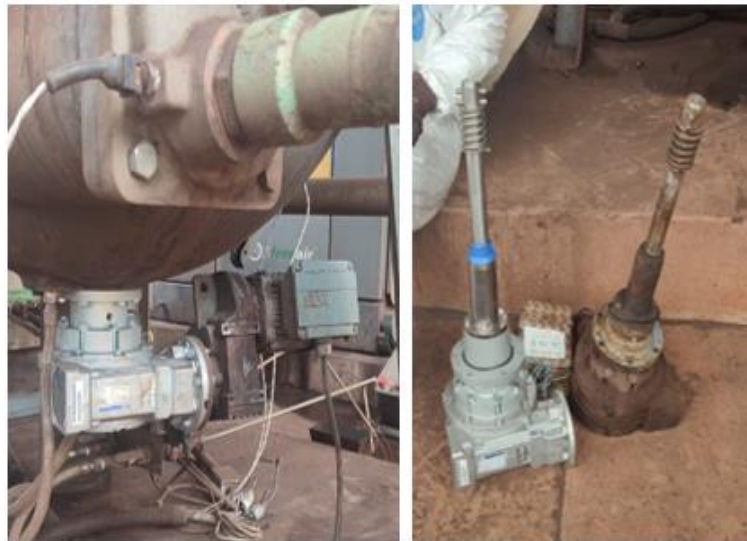
Figura 11: Instalado motoredutores nos secadores.
