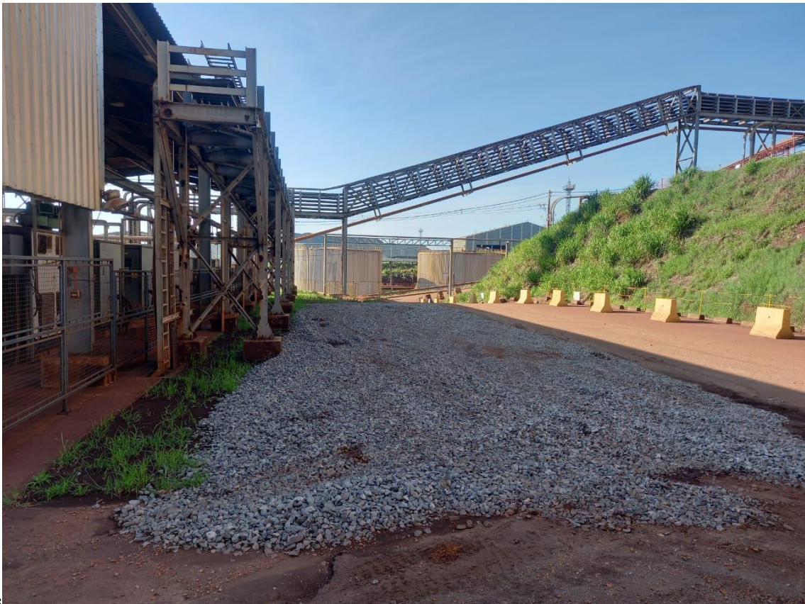
Figura 9: Aplicado brita ao redor da sala dos compressores.
