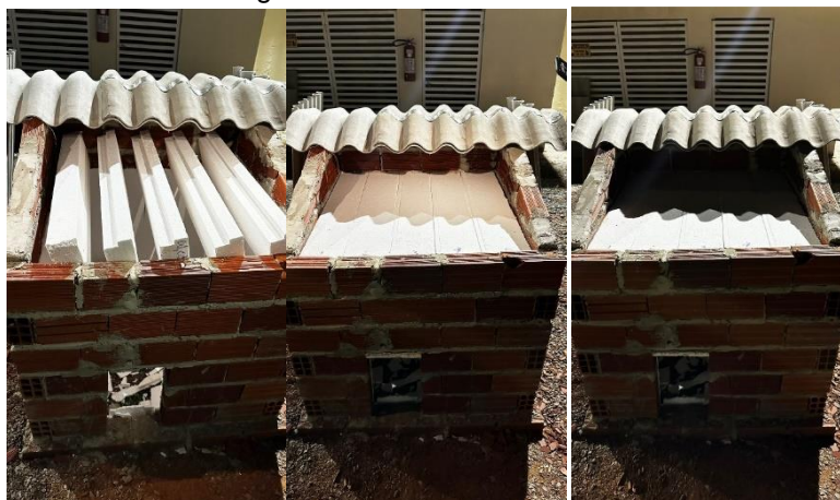
Figura 8 – Detalhes do telhado
