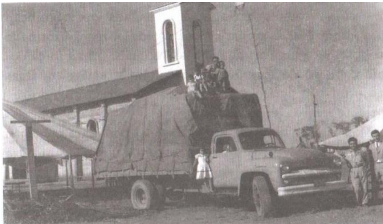
Figura 2 – Matriz Nossa Senhora da Glória em Construção (1954).
