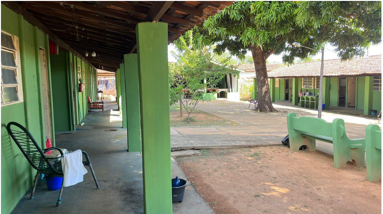
Figura 2 Pátio da Instituição de Longa Permanência de Mozarlândia
