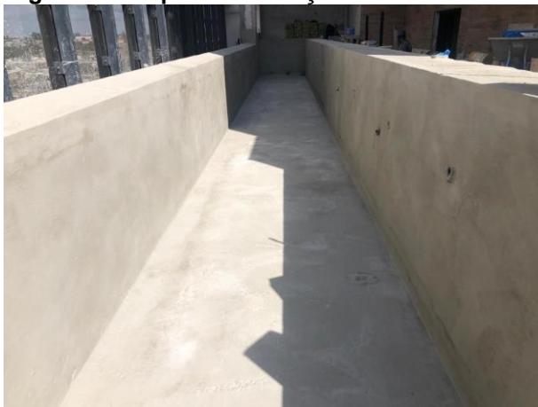
Figura 38 - Impermeabilização finalizada
