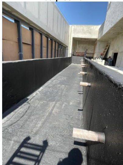
Figura 23 - Imprimação da estrutura da piscina
