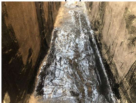
Figura 30 - Local do vazamento 2 após recomposição
