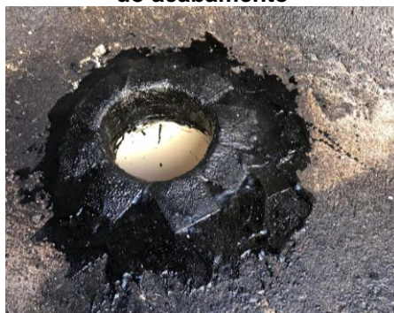
Figura 16 - Ralo após a execução do acabamento
