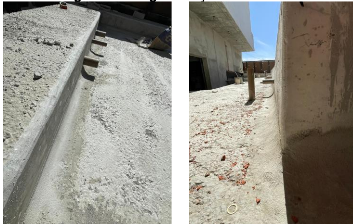
Figura 22 - Regularização da estrutura
