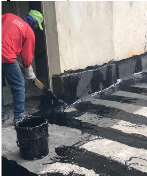
Figura 19 - Execução do banho asfáltico
