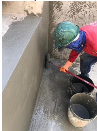
Figura 35 - Aplicação argamassa polimérica
