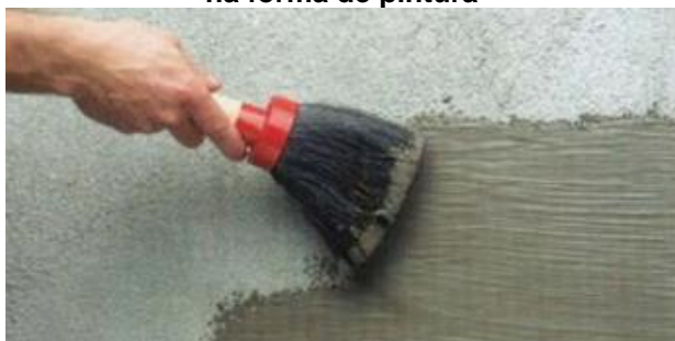
Figura 3 - Aplicação de argamassa polimérica na forma de pintura
