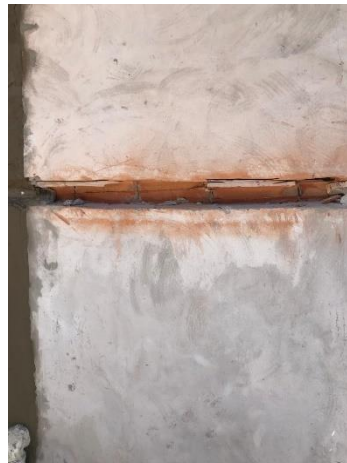
Figura 14 - Cava para virada da manta
