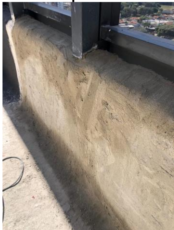
Figura 13 - Regularização da laje e paredes
