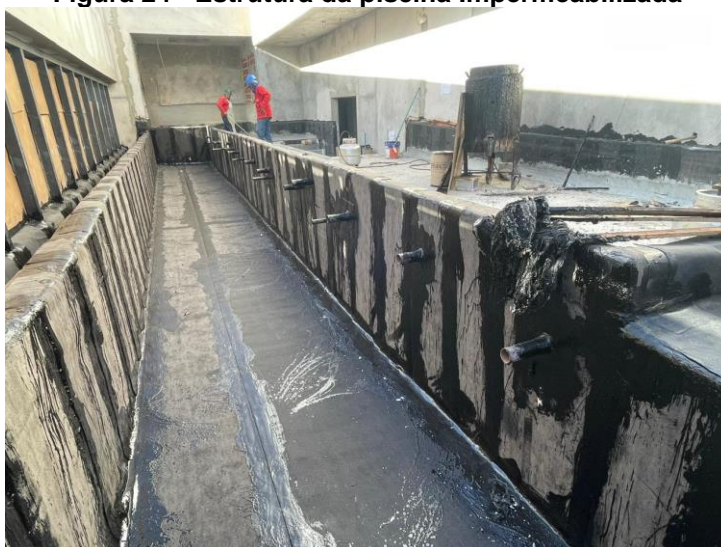
Figura 24 - Estrutura da piscina Impermeabilizada
