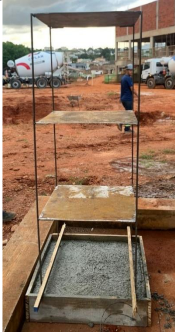
Figura 8 – Estrutura da edificação
