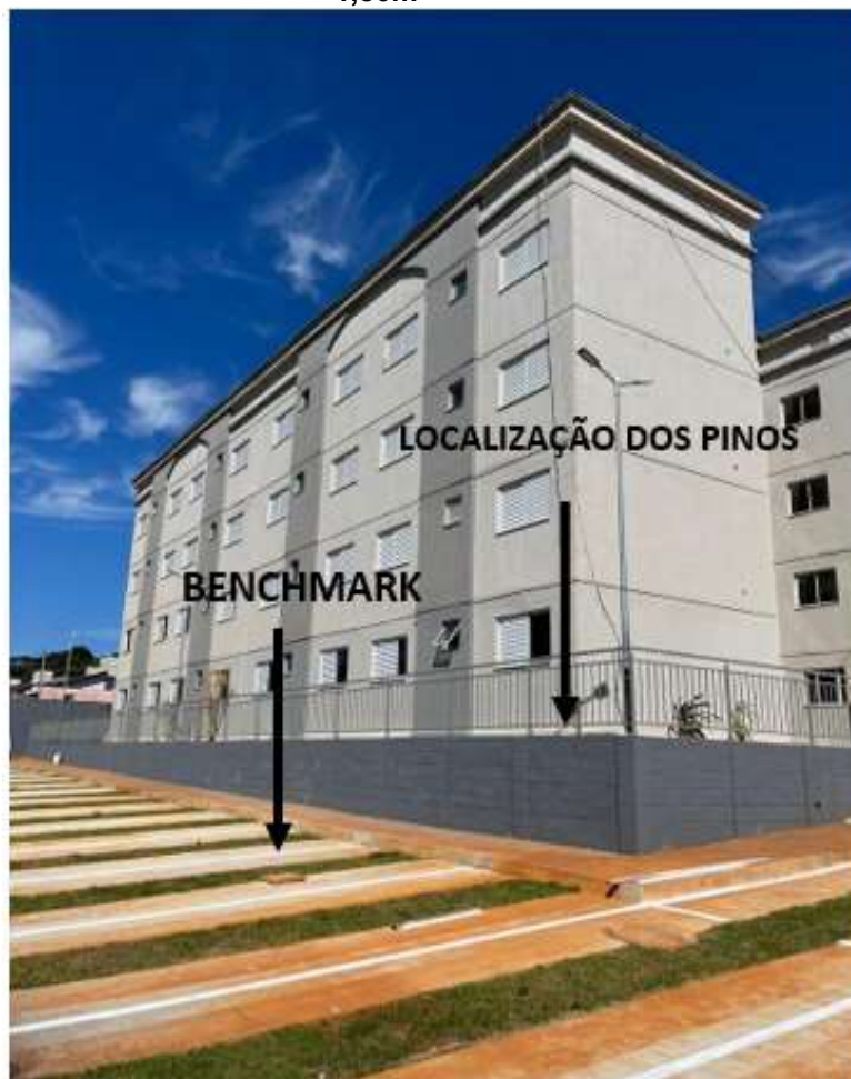
Figura 6 – Bloco B pronto com o benchmark em um nível de -1,80m
