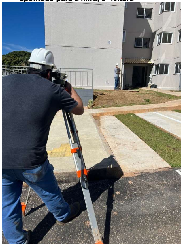
Figura 14 – Mira apoiada no bloco B, e o nível apontado para a mira, 3ª leitura
