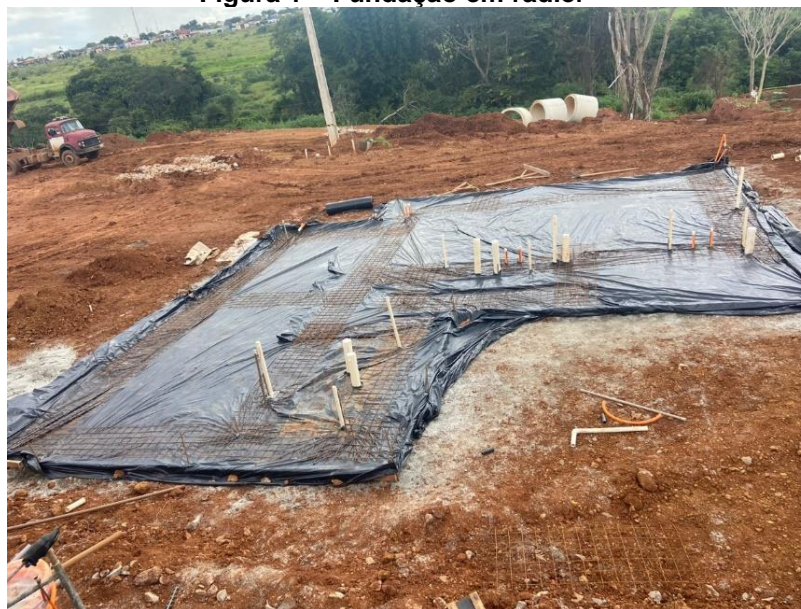
Figura 1 – Fundação em radier
