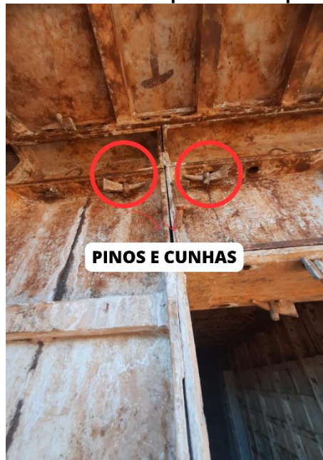
Figura 5 – Travamento dos painéis com pinos e cunha
