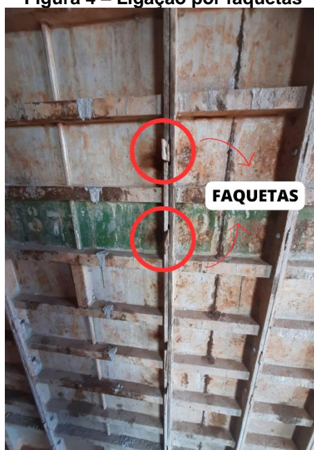
Figura 4 – Ligação por faquetas
