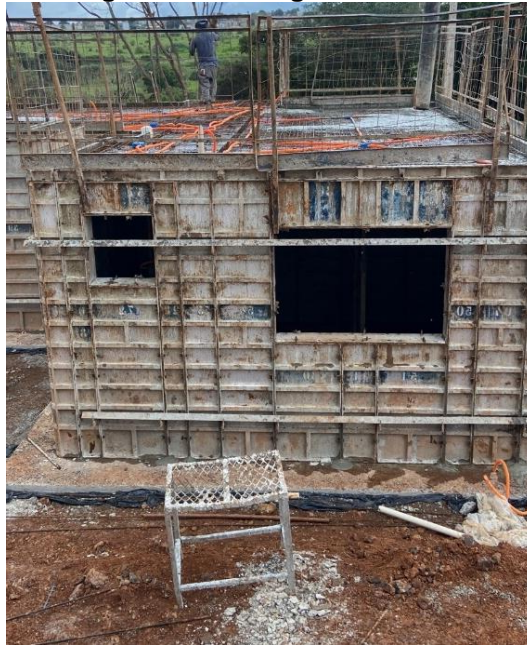
Figura 7 – Montagem da fôrma
