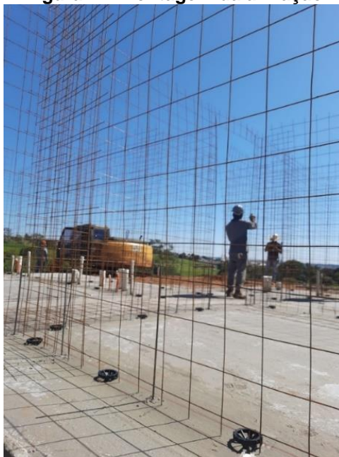
Figura 2 – Montagem da armação
