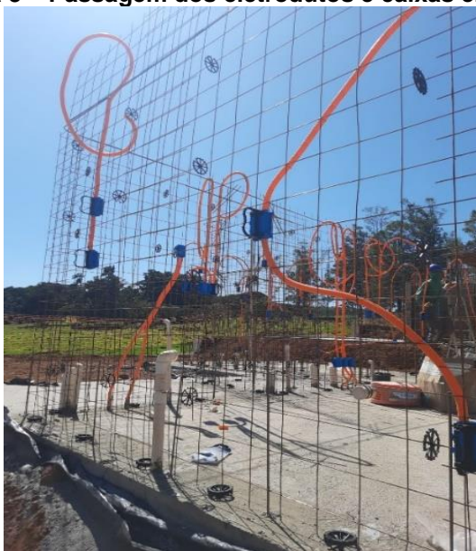
Figura 3 – Passagem dos eletrodutos e caixas elétricas
