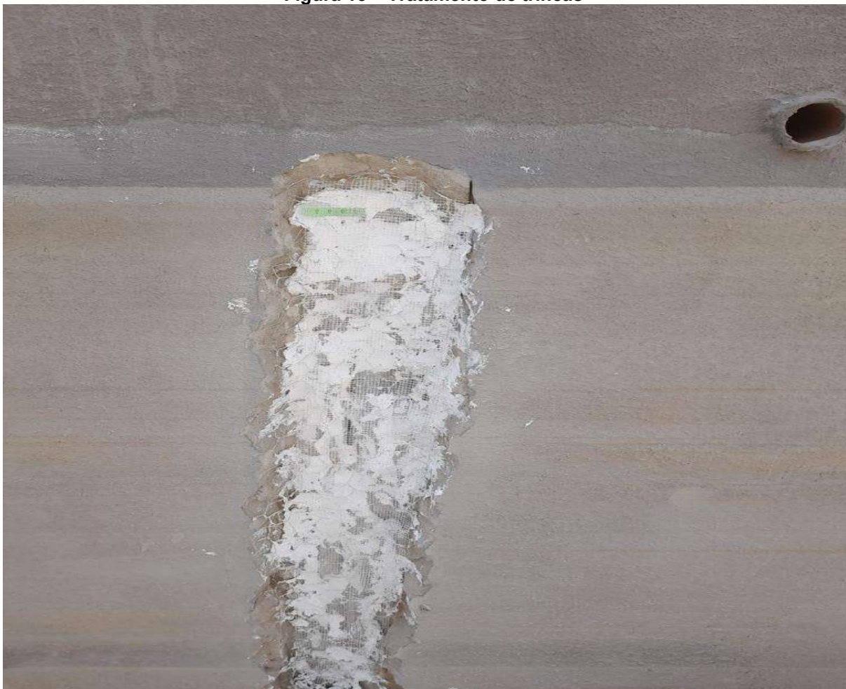
Figura 15 – Tratamento de trincas
