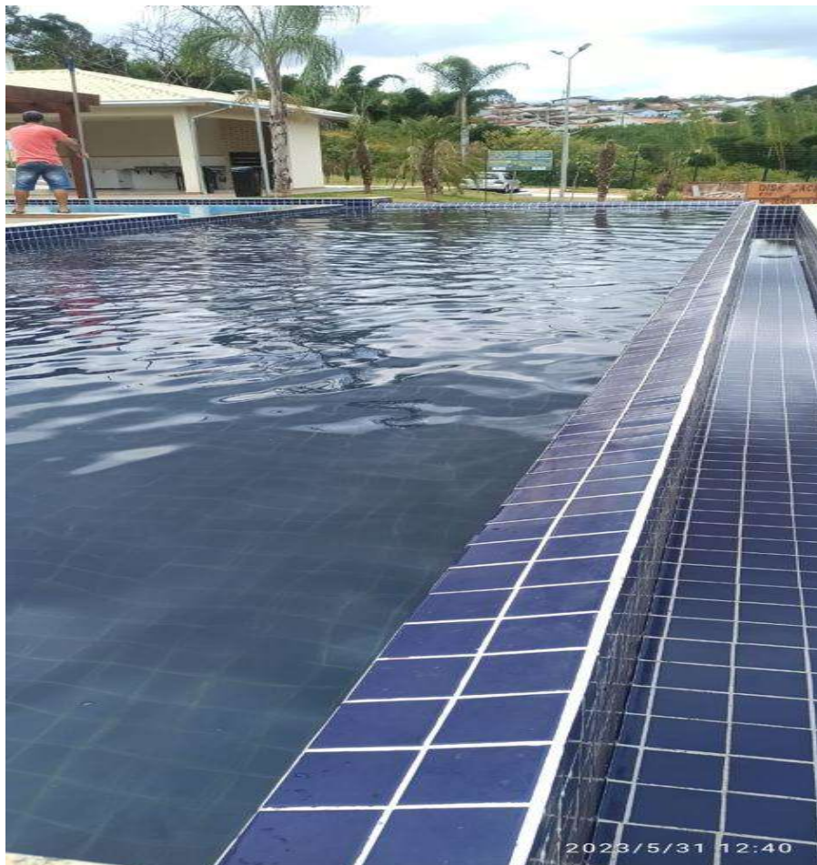
Figura 13 – Sistema de borda infinita
