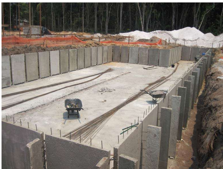
Figura 3 – Piscina em placa pré-moldada
