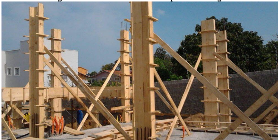
Figura 2 – Fechamento das formas para concretagem
