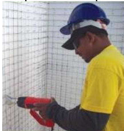
Figura 15 - Operador utilizando Soprador Térmico
