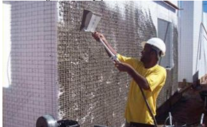
Figura 16 – Projeção do microconcreto
