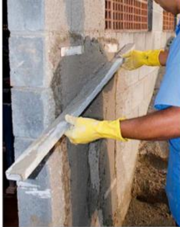
Figura 7 -Sarrafeamento do emboço entre as faixas-mestras
