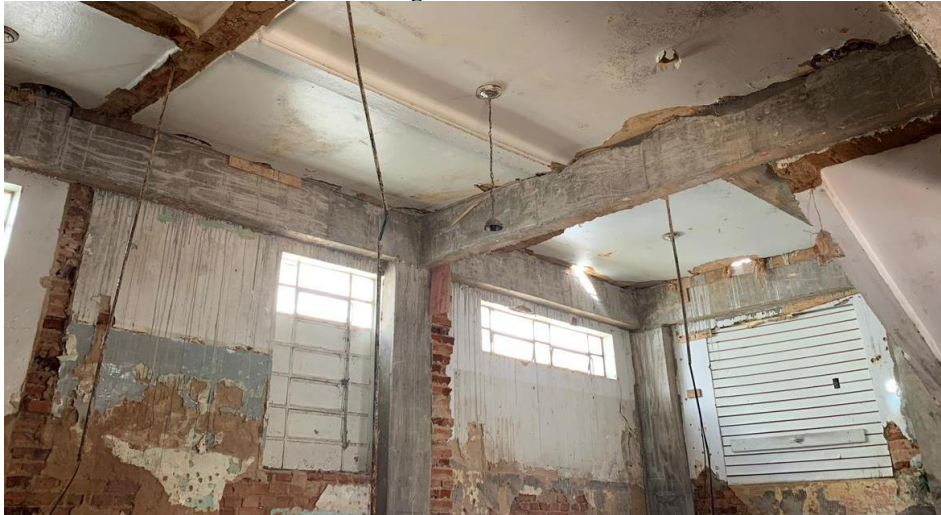
Figura 3 – Vigas de Concreto Armado
