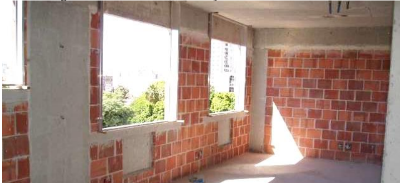
Figura 5 - Alvenaria de vedação com blocos cerâmicos
