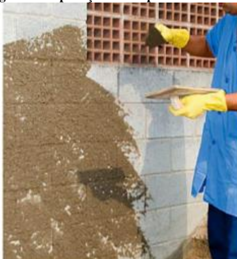
Figura 6 – Aplicação de chapisco convencional
