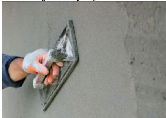
Figura 8 – Operação de reboco
