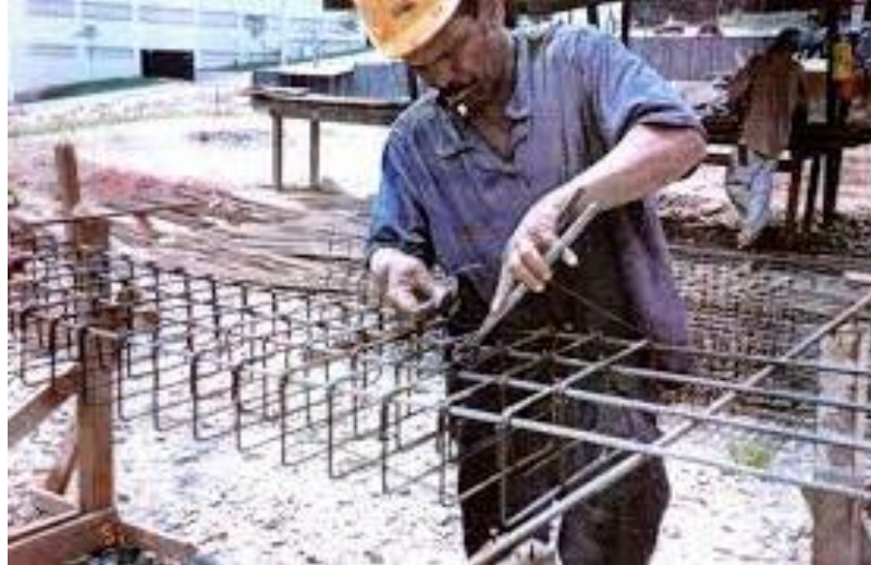
Figura 1 – Montagem dos pilares
