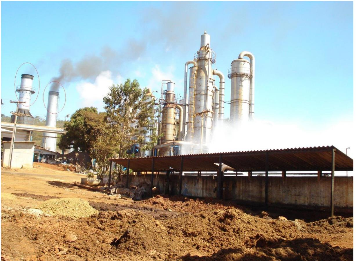
Figura 14 – Torres com filtros a base de água
