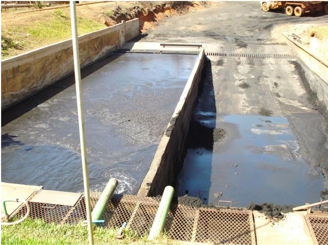
Figura 15 – Tanques de decantação com poluição captada pelos filtros
