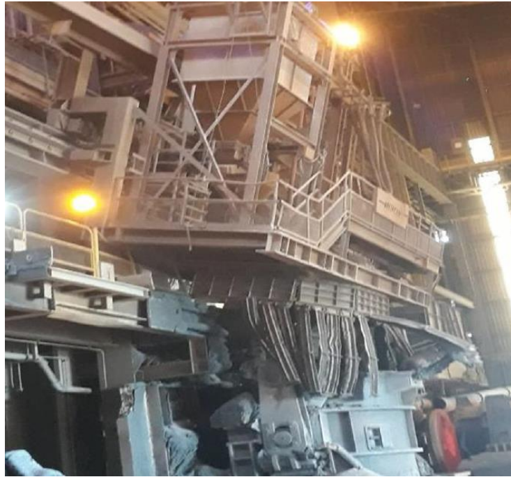
Figura 6 - Estação geral de sopro tombada após o incidente
