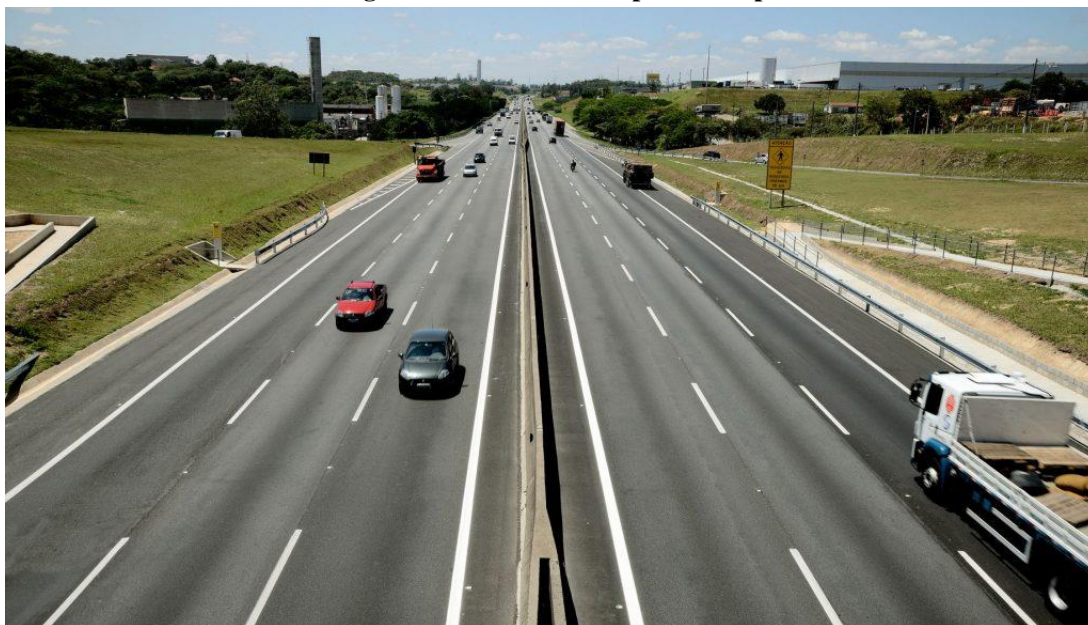
Figura 11 – Rodovia com pista múltipla
