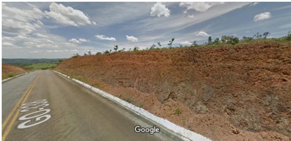
Figura 17 - Rodovia com o talude a direita
