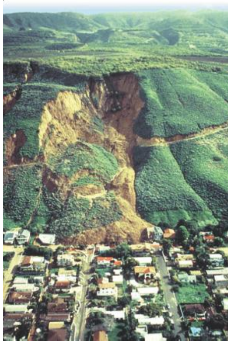
Figura 10 - Solo com escorregamento
