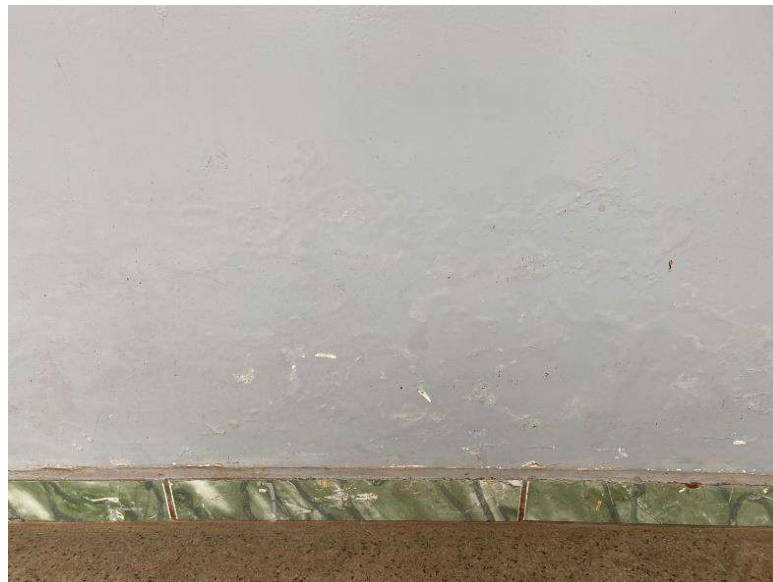
Figura 16 - Bolhas na parede de uma das salas da Escola Geraldo Luzia Vecce.
