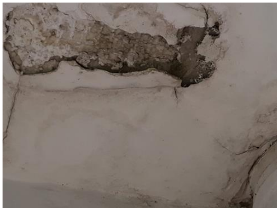
Figura 29 - Reboco comprometido 2
