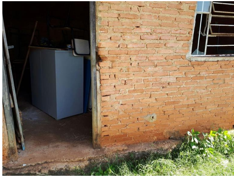
Figura 22 - Entrada no depósito que abriga a fossa
