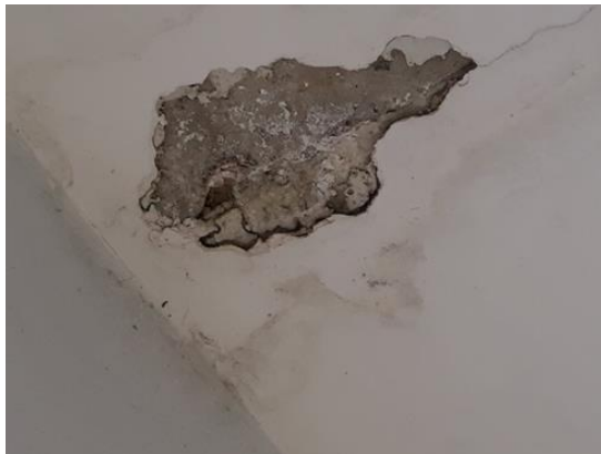
Figura 28 - Reboco comprometido 1
